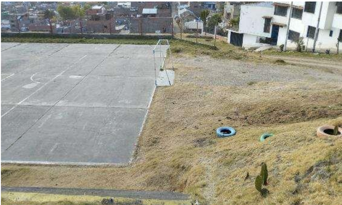
Losa deportiva sin tratamiento alguno, abandonado.
