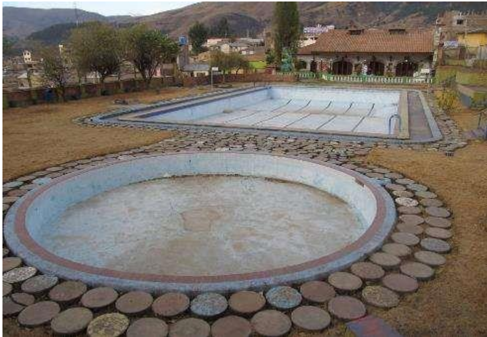
Mal estado de la piscina, completamente abandonado, ya nadie lo usa
