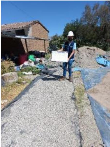
**Fotografía 01:** Vista general del proceso de secado de los agregados, ello se efectuó con el propósito de uniformizar los contenidos de humedad.
