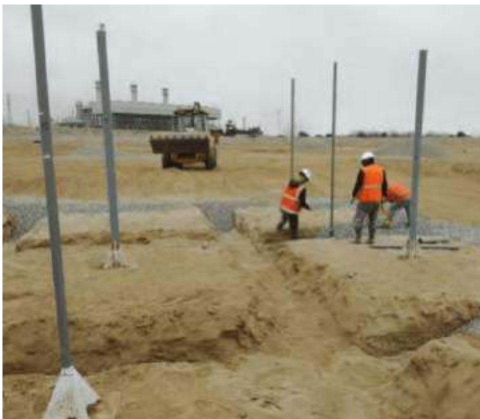
Ilustración 14. Platos de asentamiento colocados en zona de prueba
