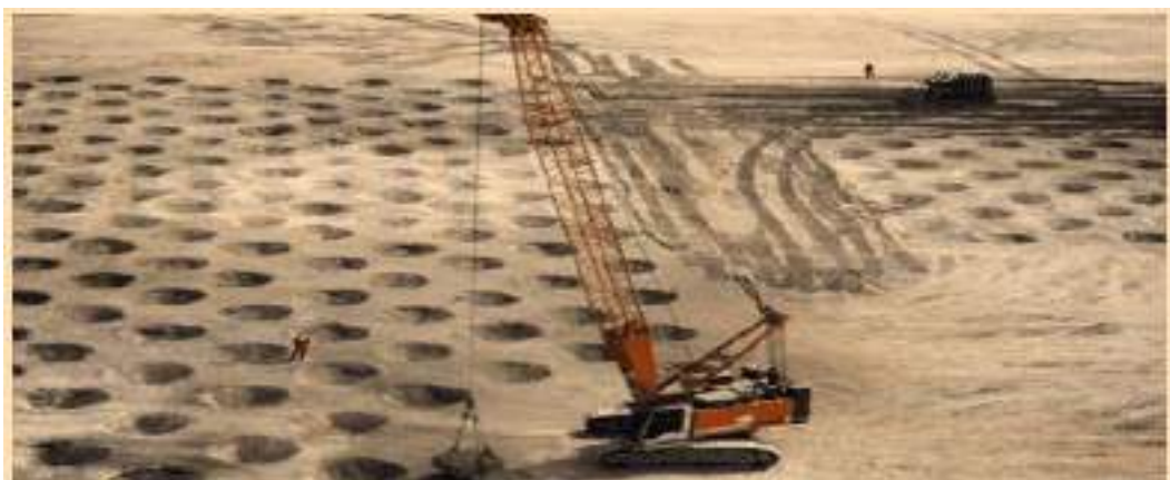
Figura 1 Compactación dinámica
