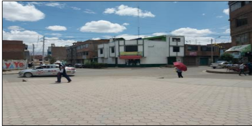
Figura N° 24: Falta de señalización de cruce peatonal en la avenida de ingreso al parque. Fuente: Propia
