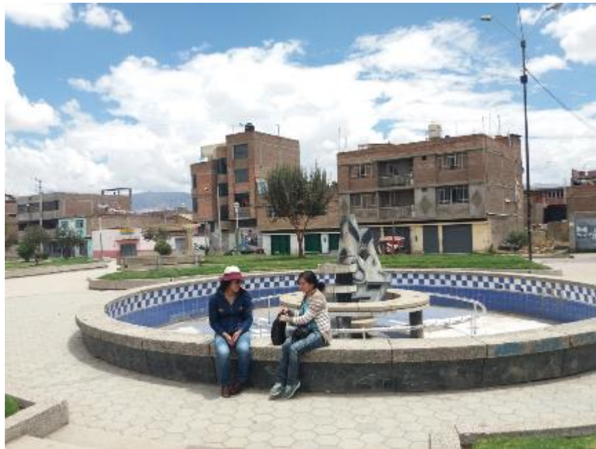
Figura N° 23: Efectos del desuso de la pileta principal y tuberías expuestas.
