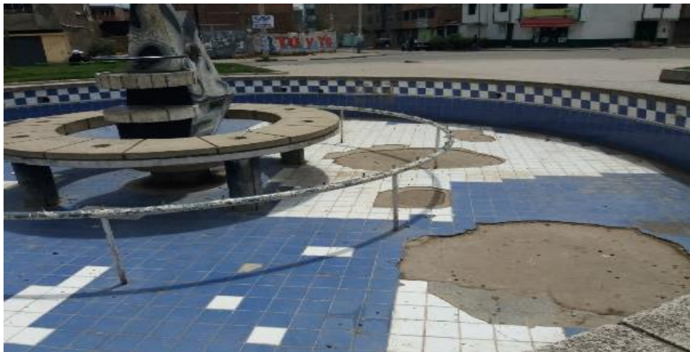
Figura N° 22: El desuso de la pileta central ha provocado que el material y sus componentes se desprendan Fuente: Propia
