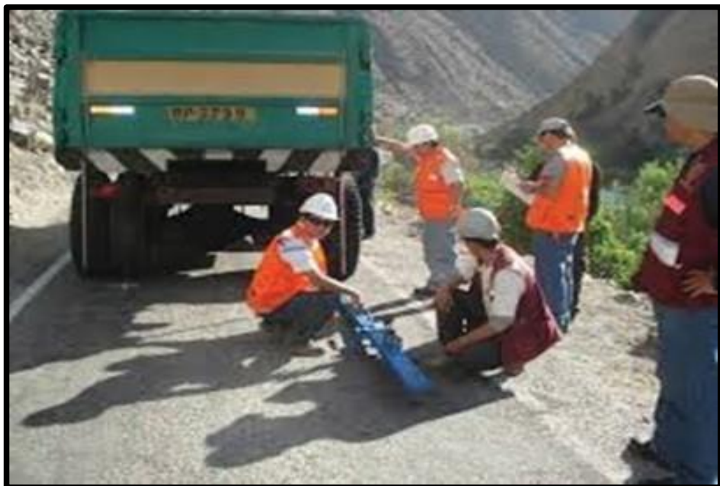
Fotografía N° 14. Medida de la deflexión empleando la Viga Benkelman (MTC E-1002)
