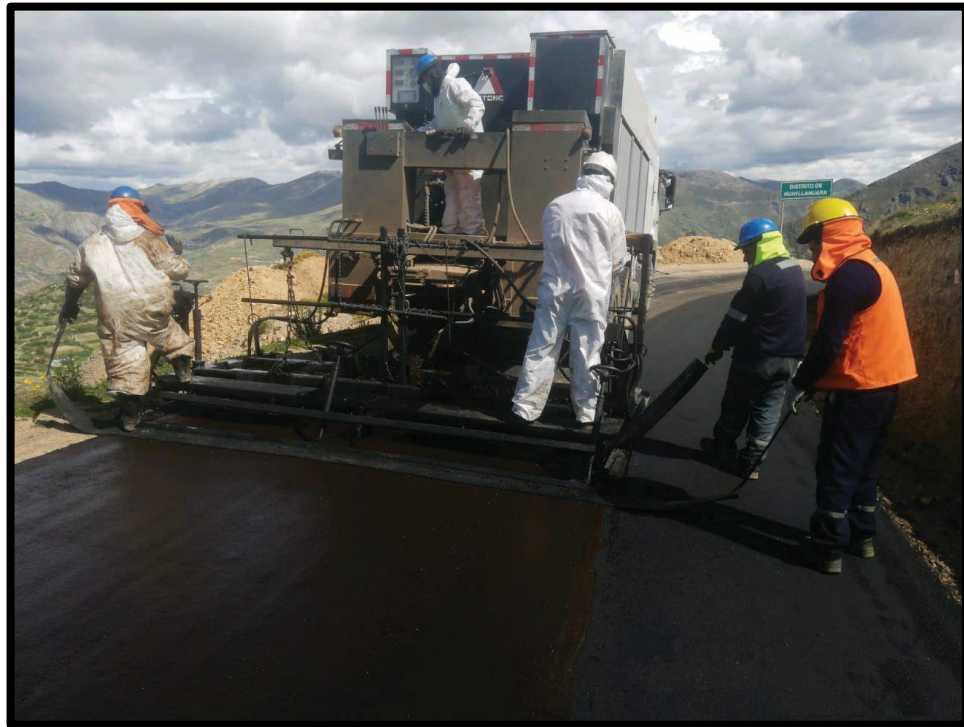
Fotografía N° 12. Colocación de mortero asfáltico (slurry seal 12 mm carretera Moya Huayllahuara)
