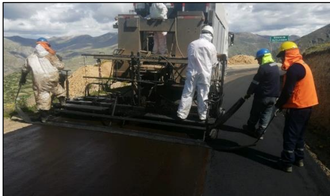
Figura 3. Aplicación de Slurry seal.
