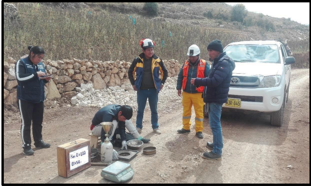
Fotografía N° 11. Ensayo densidad de campo (Base no estabilizado)
