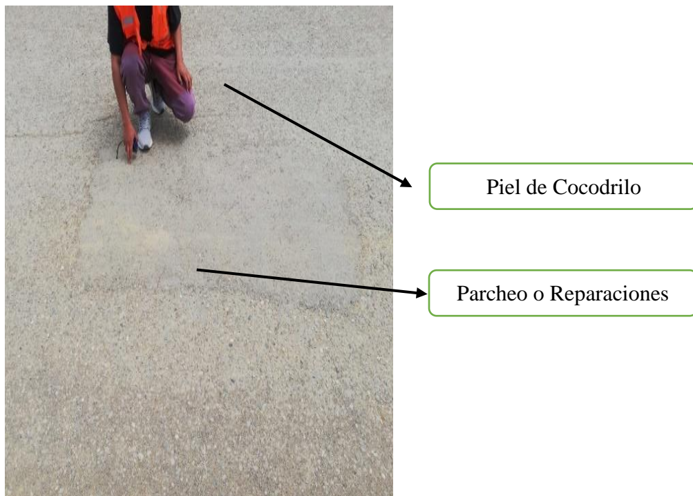
Figura 23. Se visualiza las fallas parcheo y piel de cocodrilo
