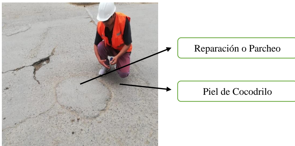
Figura 19. Se visualiza las fallas parcheo y piel de cocodrilo
