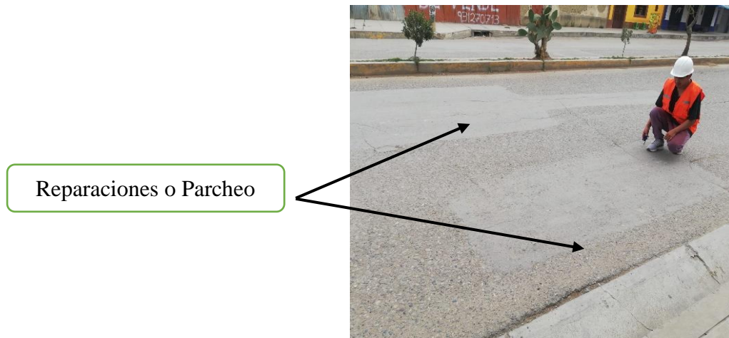
Figura 13. Se visualiza la fallas parcheo
