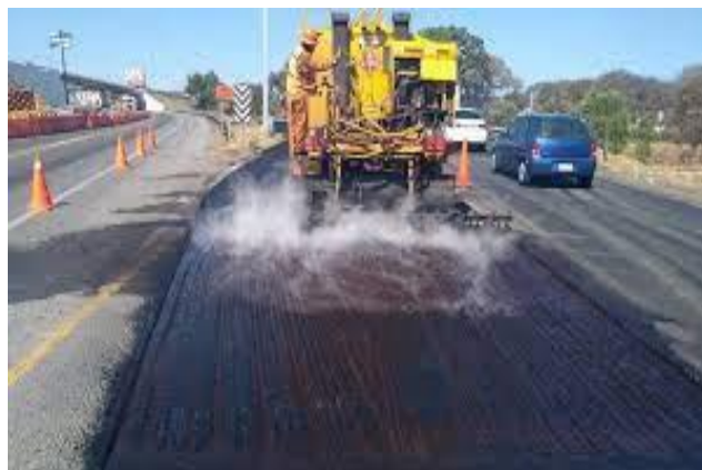
Fresado de la capa asfáltica
