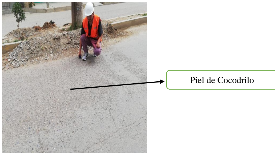
Figura 14. Se visualiza las fallas piel de cocodrilo
