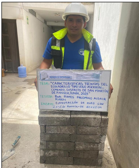
Fotografía N°17: Elaboración de muro de 0.60m x 0.60 m con la adición al 2.5% de aserrín mineralizado.
