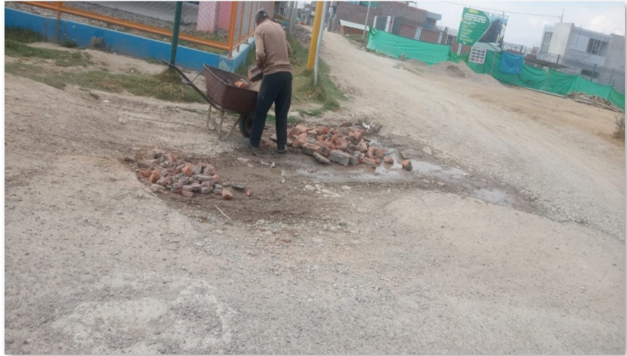
Figura 1: Pavimento del Jr. Tupac Amaru: Jr. Andrés Avelino Cáceres
