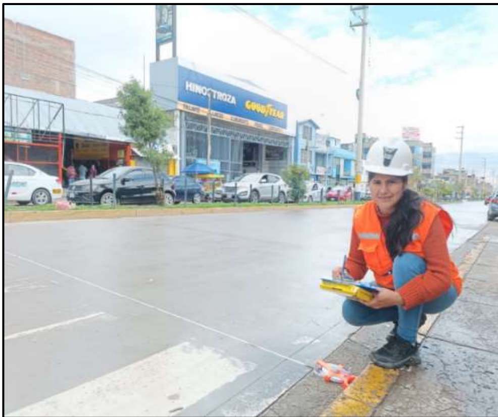
Fotografía 6: Medición del ancho de carril, lugar Av. Mariátegui.
