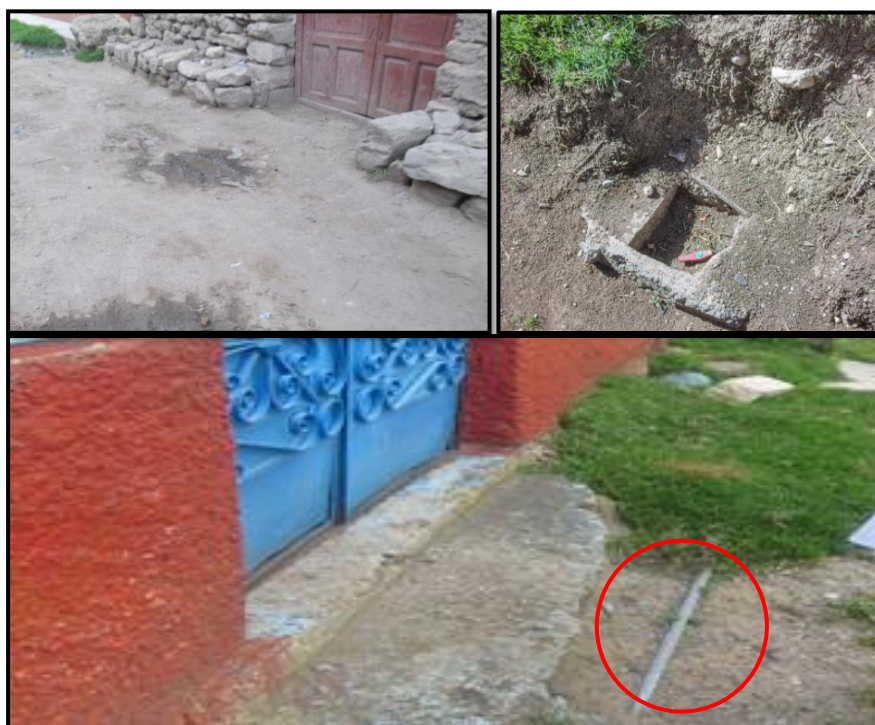
Figura 5.19 Conexiones Domiciliarias Existentes
