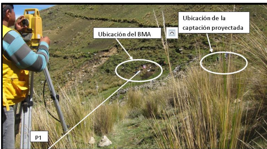
Levantamiento topográfico, de la Captación proyectada
