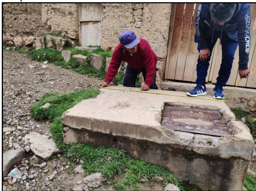
Figura 5.18 Cámara Rompe Presión Tipo VII
