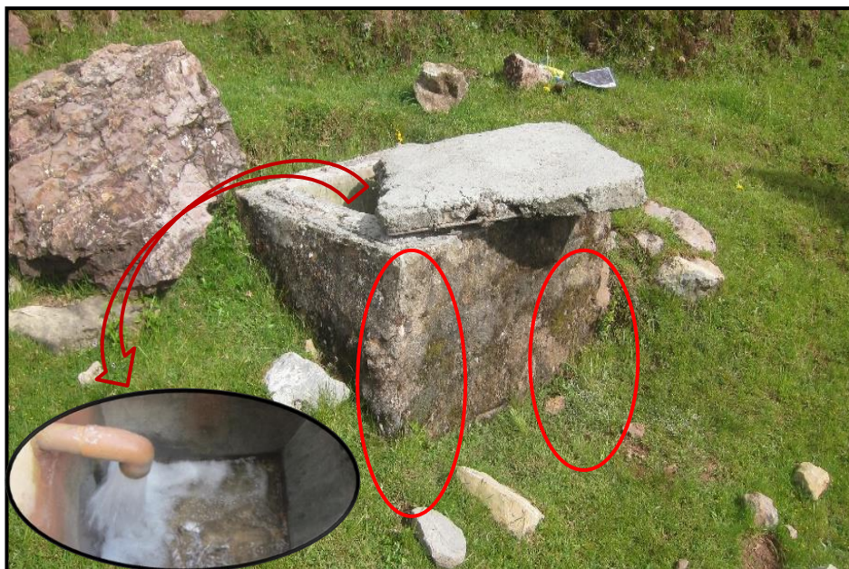
Figura 5.9 Cámara Rompe Presión Tipo VI - 07
