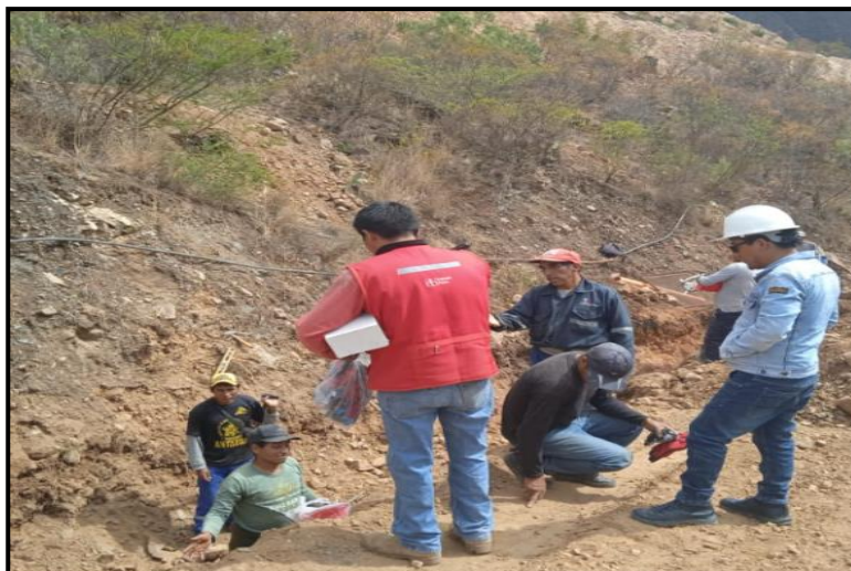
Figura 4.5 Reparación por Parte de la JASS en la Red de Distribución
