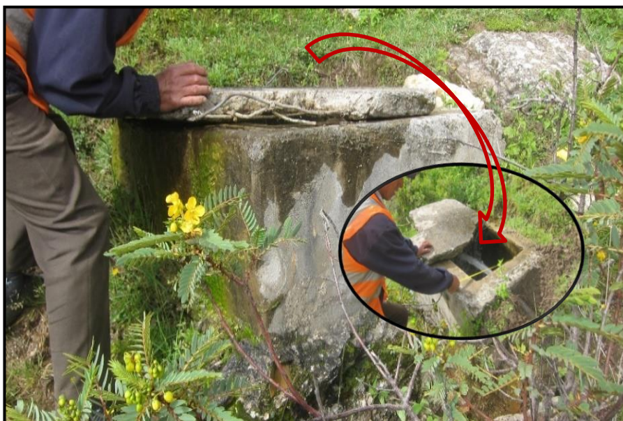
Figura 5.11 Cámara Rompe Presión Tipo VI - 09
