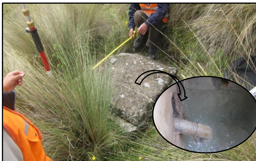
Figura 5.4 Cámara Rompe Presión Tipo VI - 02
