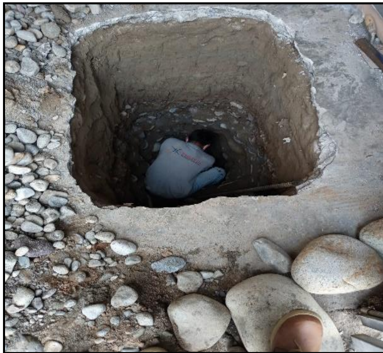
Figura 2 Calicata (con fines de cimentación)
