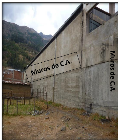
Figura 42 Muros estructurales perimétricos en Sótano
