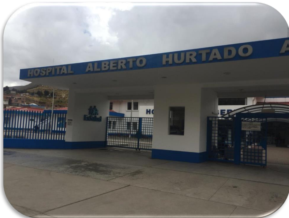
Descripción: El ingreso al Hospital Alberto Hurtado Abadia La Oroya
