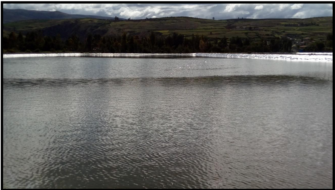
Fotografía 8. Vista de la Poza 03 (laguna facultativa) de la Planta de Tratamiento de Aguas Residuales – zonal Jauja.
