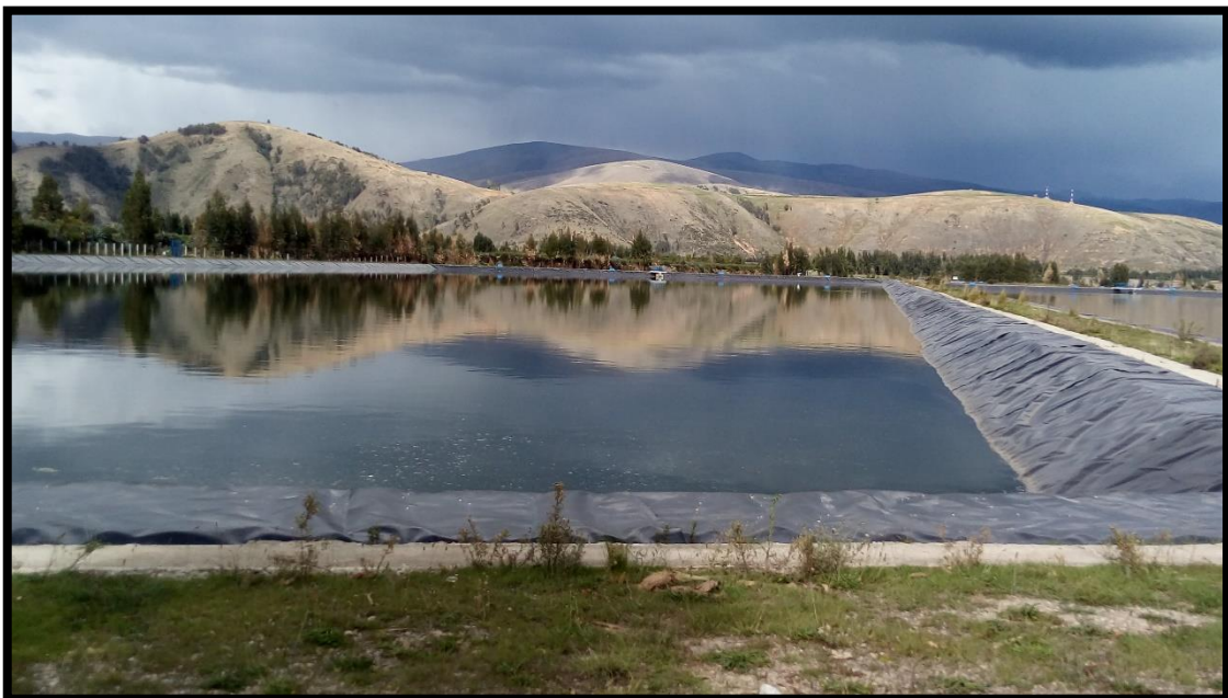
Fotografía 6. Vista de la Poza 01 (laguna anaerobia) de la Planta de Tratamiento de Aguas Residuales – zonal Jauja.
