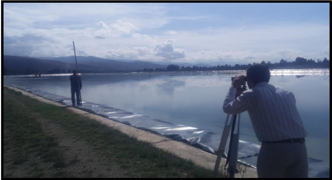
Fotografía 5. Levantamiento topográfico de la Planta de tratamiento de aguas residuales zonal – Jauja, laguna anaerobia.
