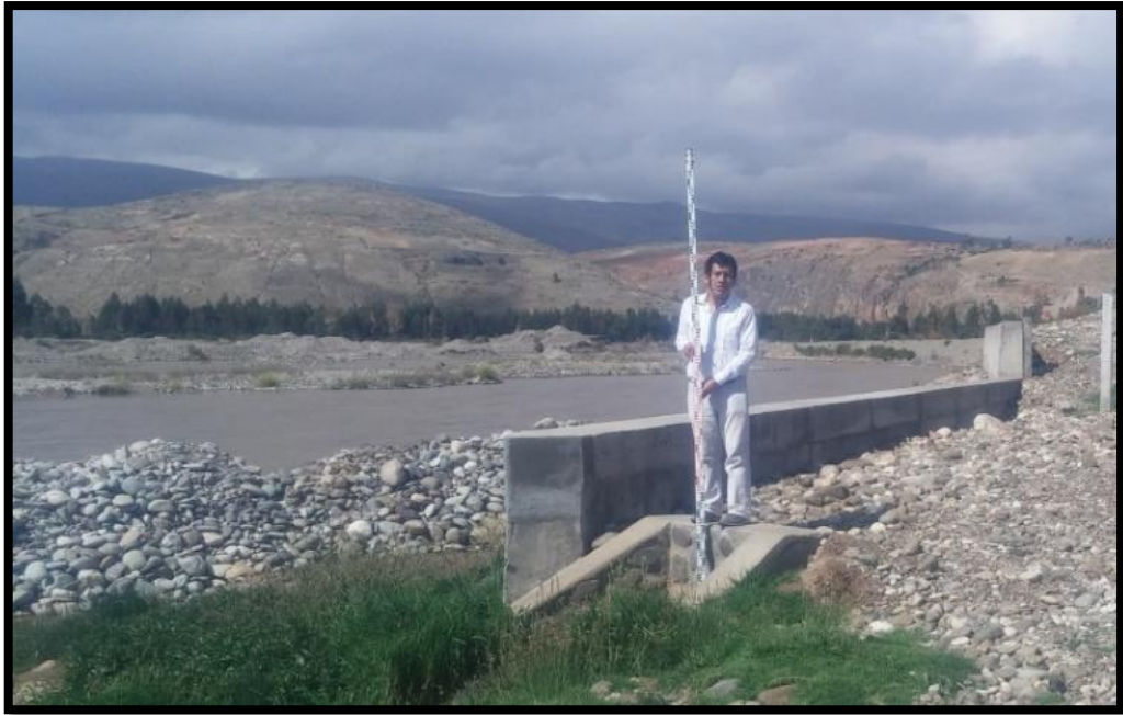
Fotografía 4. Levantamiento topográfico de canal en la Planta de tratamiento de aguas residuales zonal – Jauja, para la determinación de pendientes y el cálculo del caudal.
