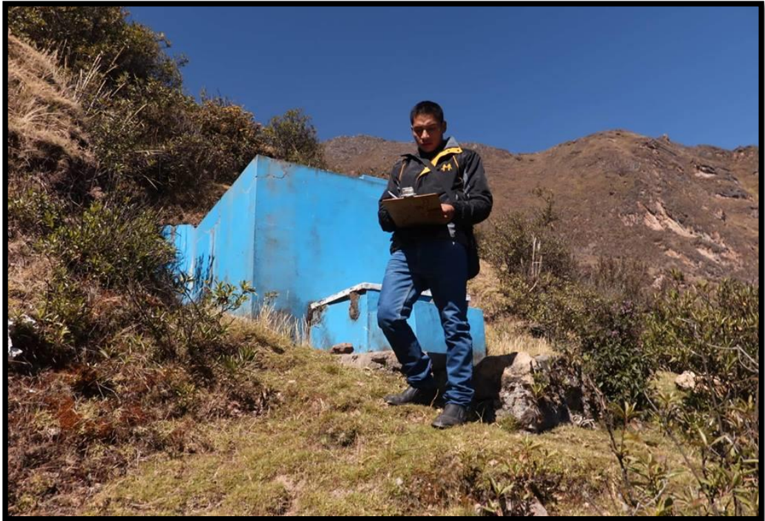
Fotografía N° 07. Verificación de la captación.
