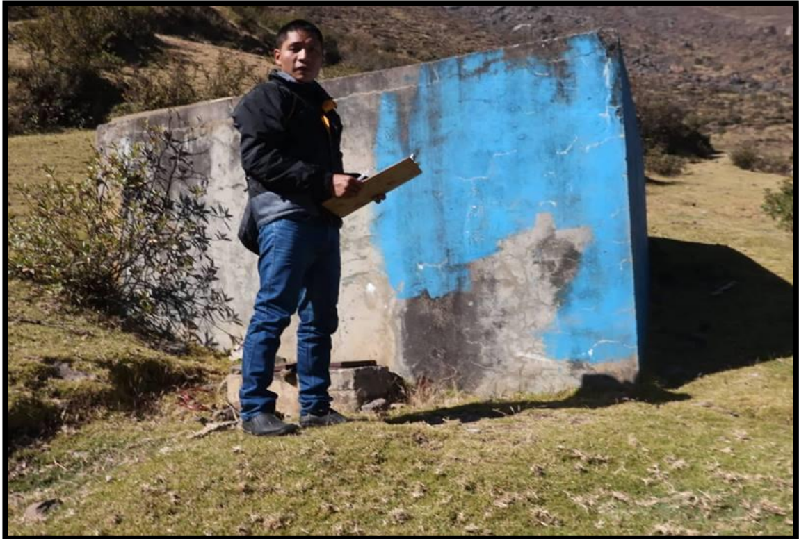
Fotografía N° 05. Verificación del reservorio existente.
