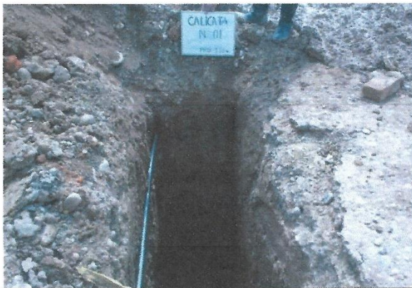
Foto N° 2 Vista de la calicata n° 1, Profundidad de 3.00 m
