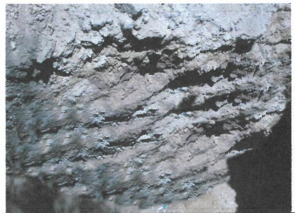
Foto N° 5 Vista de la calicata n° 2, Profundidad de 3.00 m
