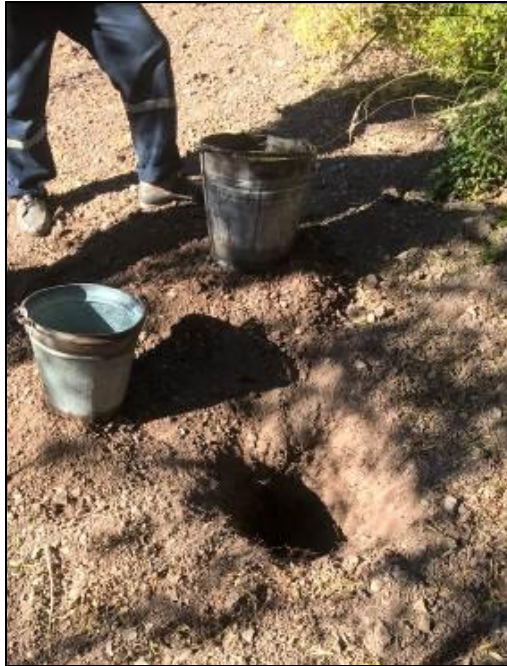
Foto 1 Preparación de Calicata
