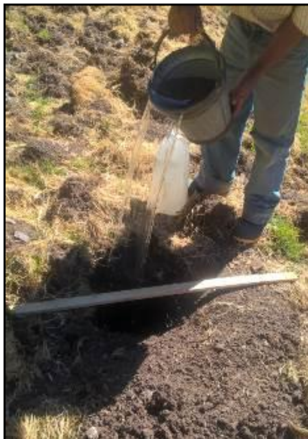
Foto 6 Vertiendo agua en la calicata para empezar el ensayo
