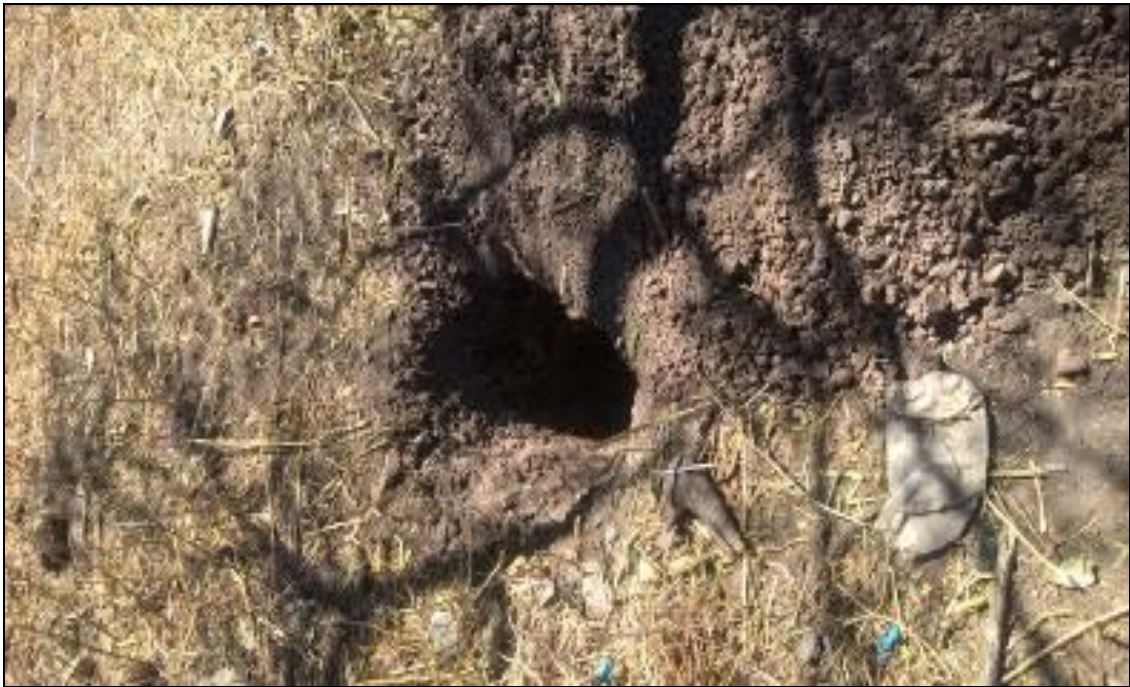
Foto 9 Preparación de Calicata
