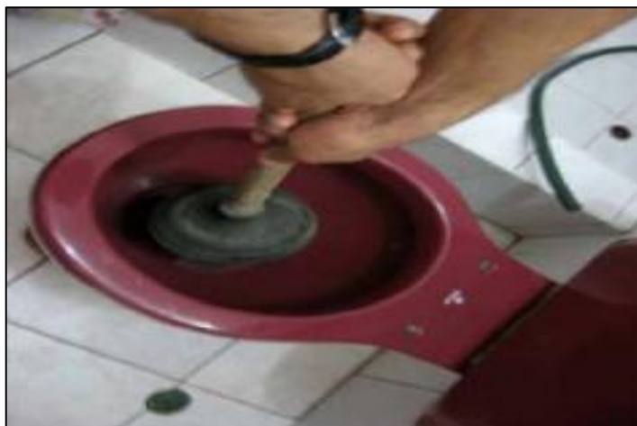
Figura 10: Mantenimiento de inodoro en caso de atoro.
