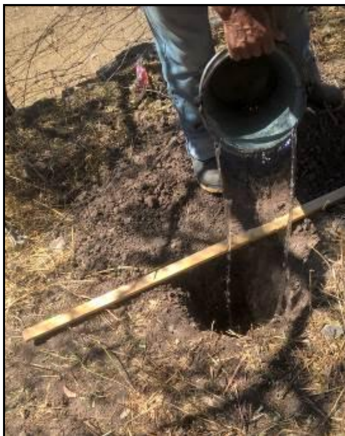
Foto 10 Vertiendo agua en la calicata para empezar el ensayo
