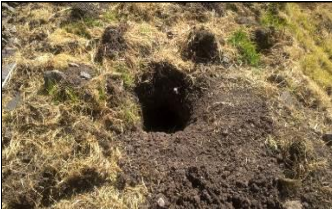
Foto 5 Preparación de Calicata
