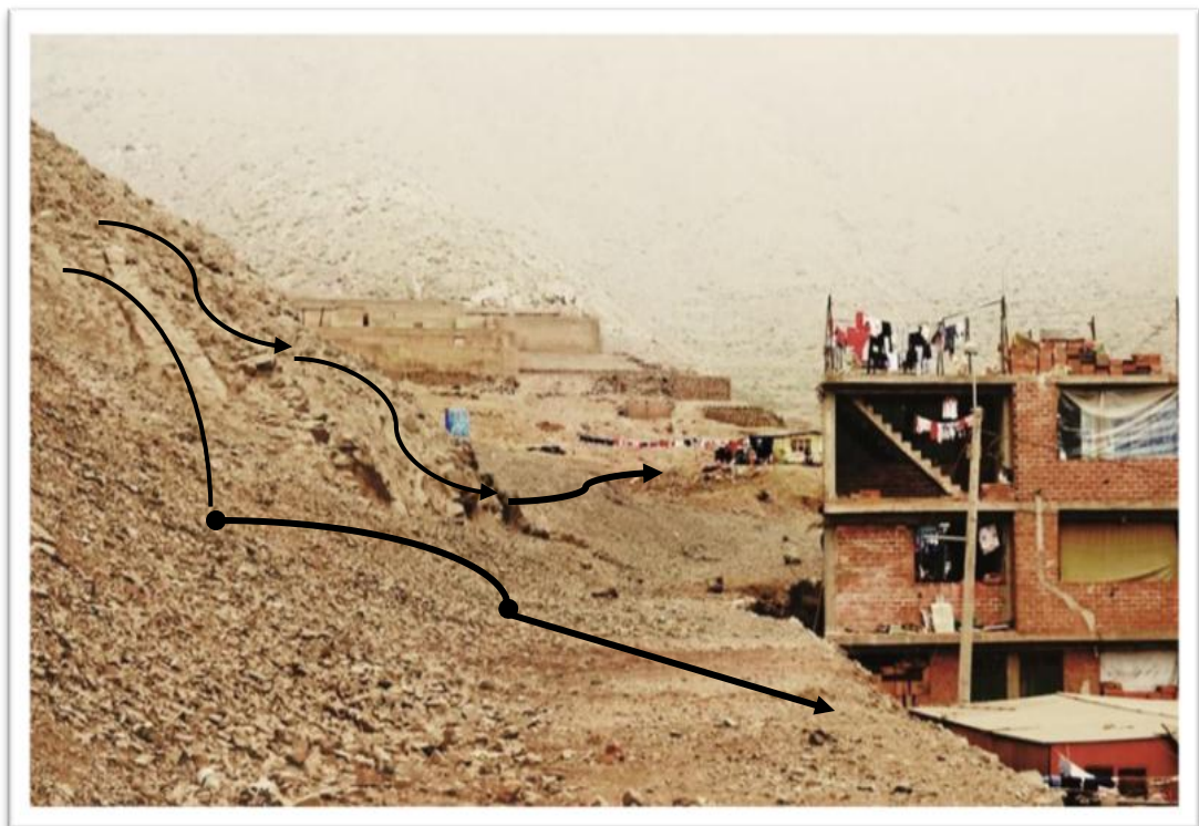
Figura 18 Mostrando tipo de material (grava limoso) depositado encima del macizo rocoso, en estado seco , taludes promedio de 5m de altura ,zona altamente riesgosa AAHH San Juan de Pariachi. Ate.
