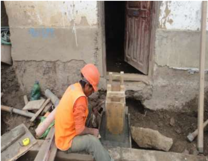
TRABAJOS DE REPOSICIÓN DE CAJAS DE CONCRETO PARA AGUA POTABLE Y DESAGÜE SANITARIO EN DIFERENTES CALLES DE COCHABAMBA GRANDE
