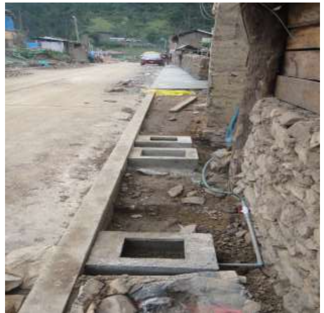
TRABAJOS DE REPOSICIÓN DE CAJAS DE CONCRETO PARA AGUA POTABLE Y DESAGÜE SANITARIO EN DIFERENTES CALLES DE COCHABAMBA GRANDE
