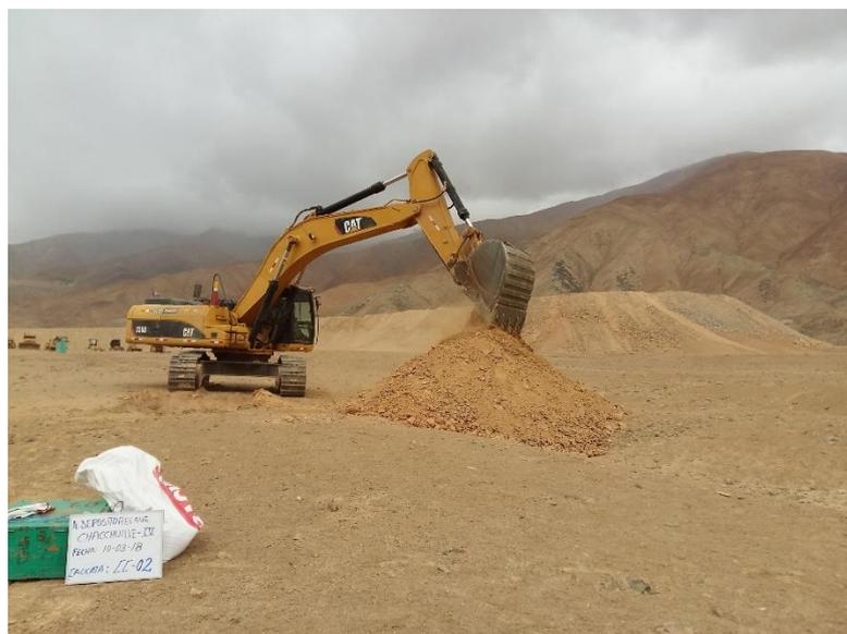
Figura 14. Excavación de calicatas CC-02 con maquinaria dentro del dique del depósito de relaves proyectado
