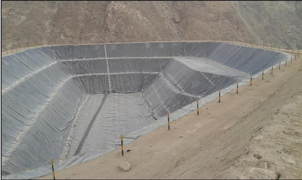
*Figura 6. Impermeabilización del vaso del depósito de relaves con geomembrana.*
