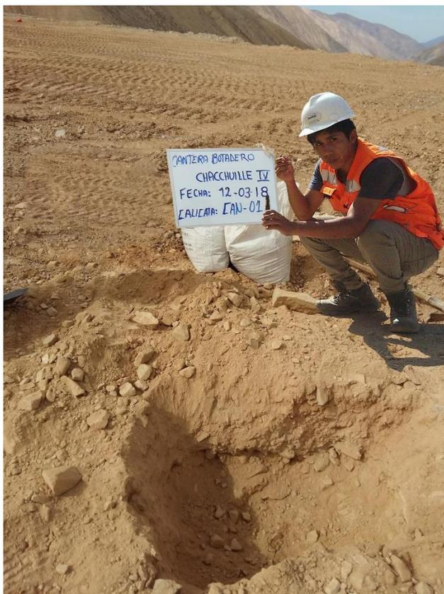
*Figura 15 Excavación de calicatas de cantera dentro del vaso del depósito de relaves proyectado*
