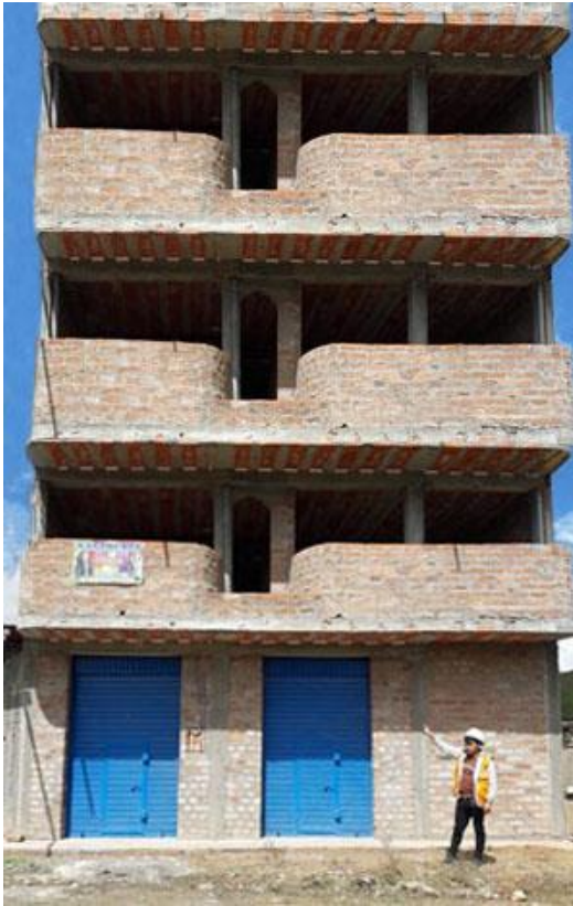
Fotografía 1. Fachada de la vivienda de albañilería analizado con ambos softwares.
