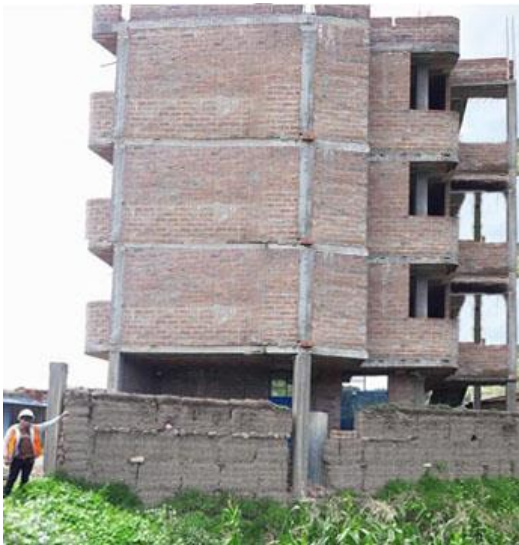
Fotografía 2. Vista lateral de la vivienda de albañilería analizado con ambos softwares.
