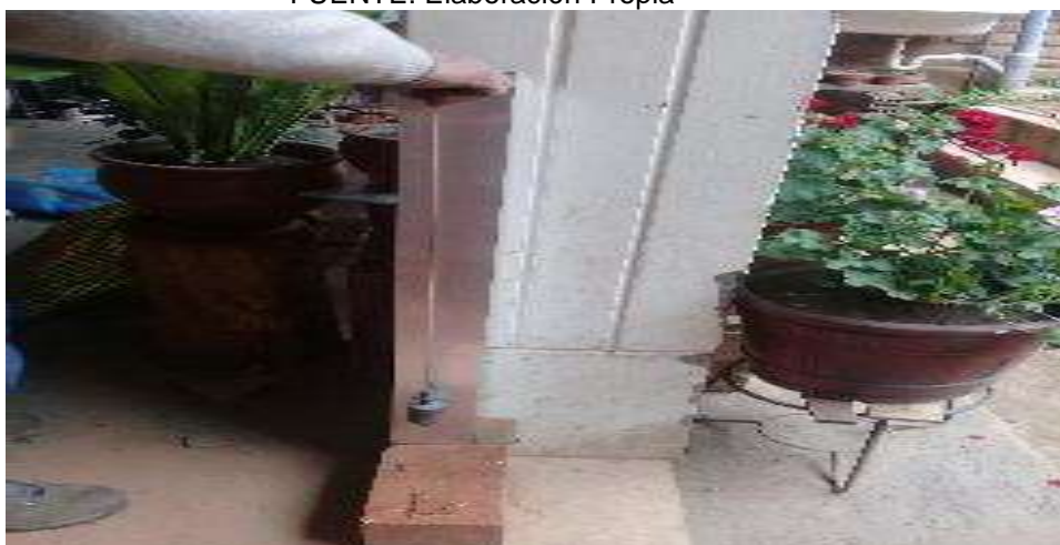
Figura 61. Verificación de horizontalidad con plomada FUENTE: Elaboración Propia
