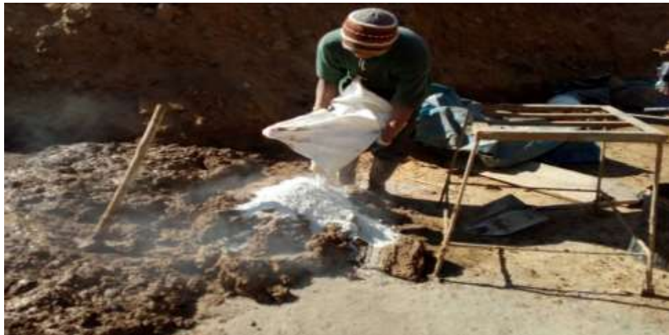
Figura 49. Incorporación del insumo puzolánico en la masa cerámica FUENTE: Imagen Propia
