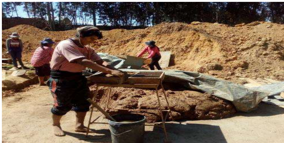
Figura 9. Fabricación del ladrillo en forma artesanal Fuente: Imagen Propia
