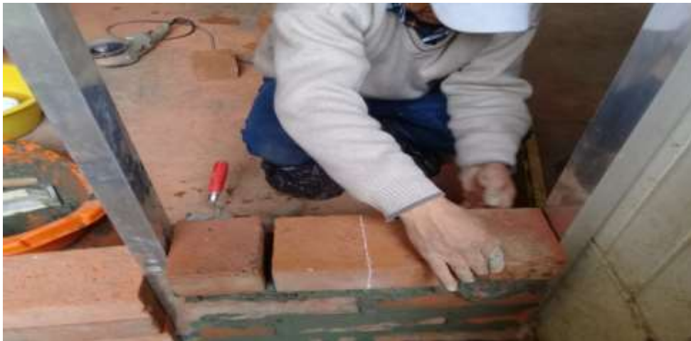
Figura 62. Asentamiento de ladrillos por mano de obra calificada FUENTE: Elaboración Propia
