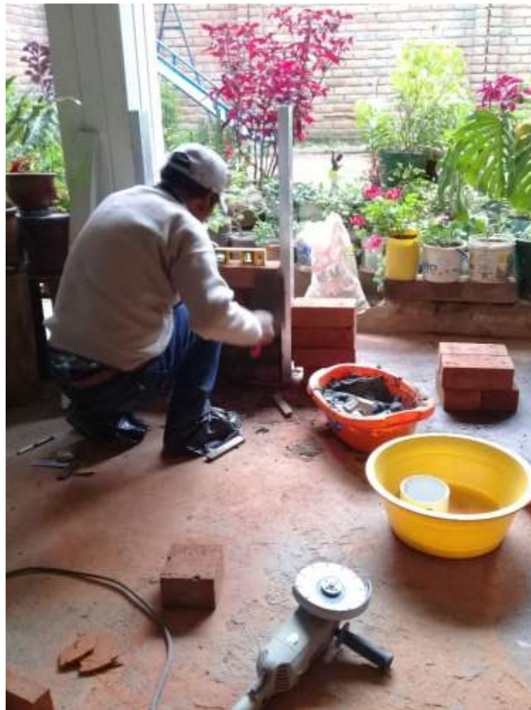
Figura 65. Verificación de horizontalidad con nivel de mano FUENTE: Elaboración Propia
