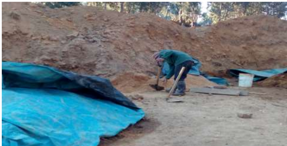
Figura 12. Extracción del material arcilloso FUENTE: Imagen Propia
