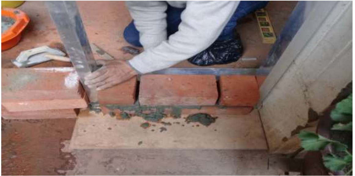
Figura 64. Elaboración de muretes alineados en sus 4 lados FUENTE: Elaboración Propia
