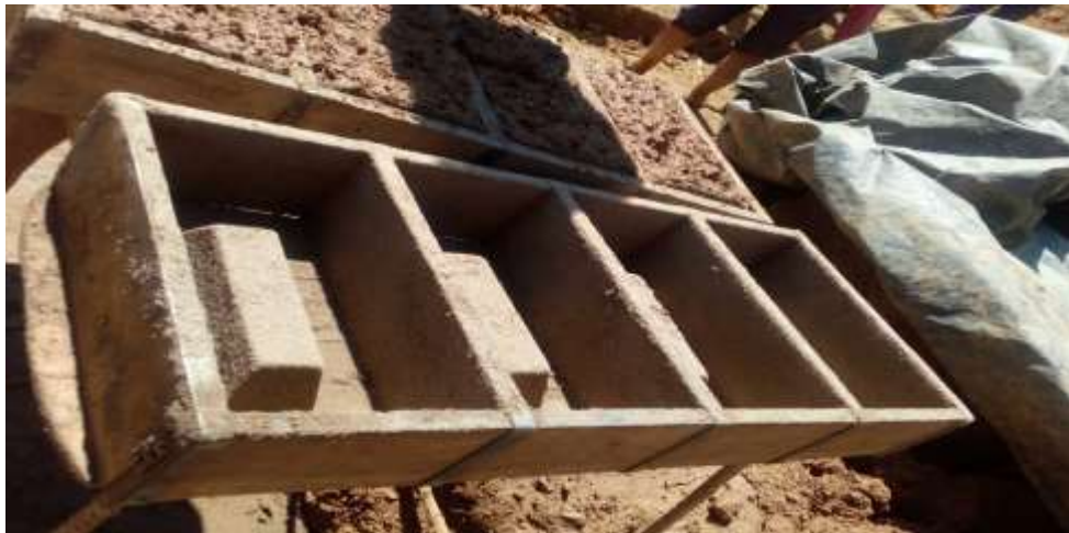
Figura 14. Gaveras de madera cepillada FUENTE: Imagen Propia
