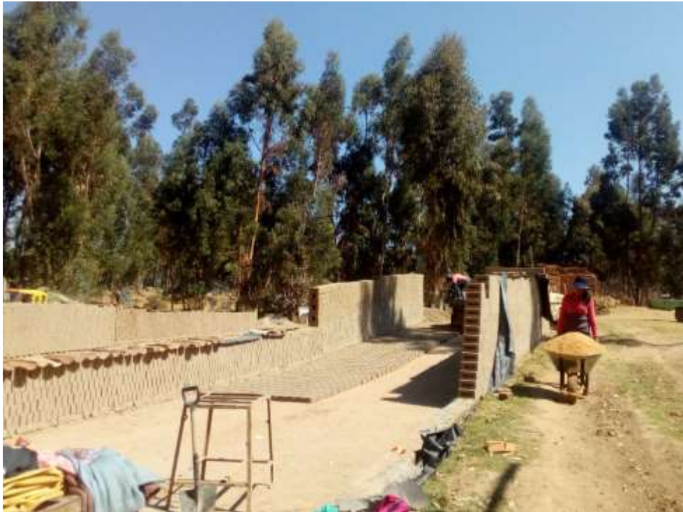
Ladrillera de Saños Chico
