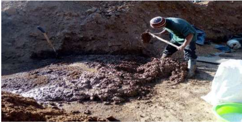
Figura 48. Mezcla de arcilla y agua manualmente FUENTE: Imagen Propia
