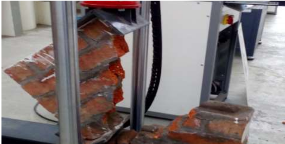
Figura 86. Murete de ladrillo artesanal donde se observa la falla diagonal en las juntas
