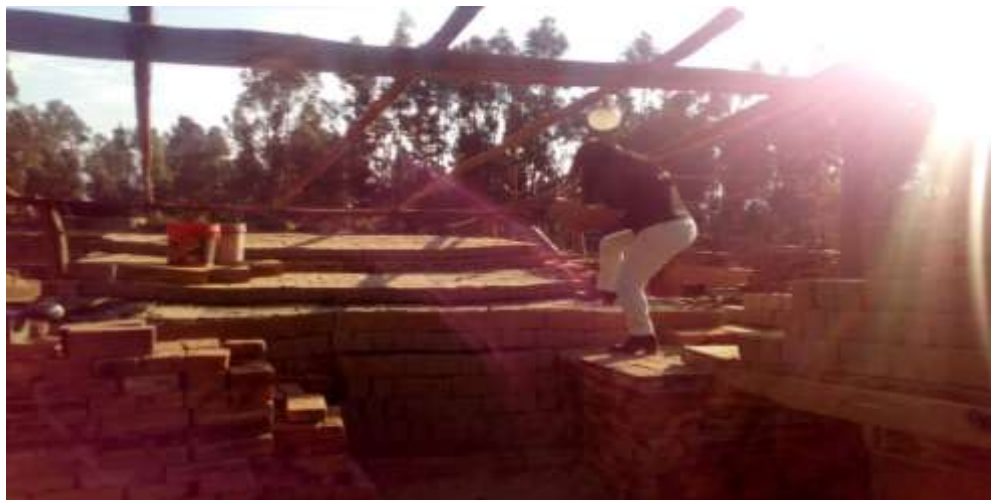
Figura 44. Unidades de albañilería siendo apiladas al horno FUENTE: Imagen Propia
