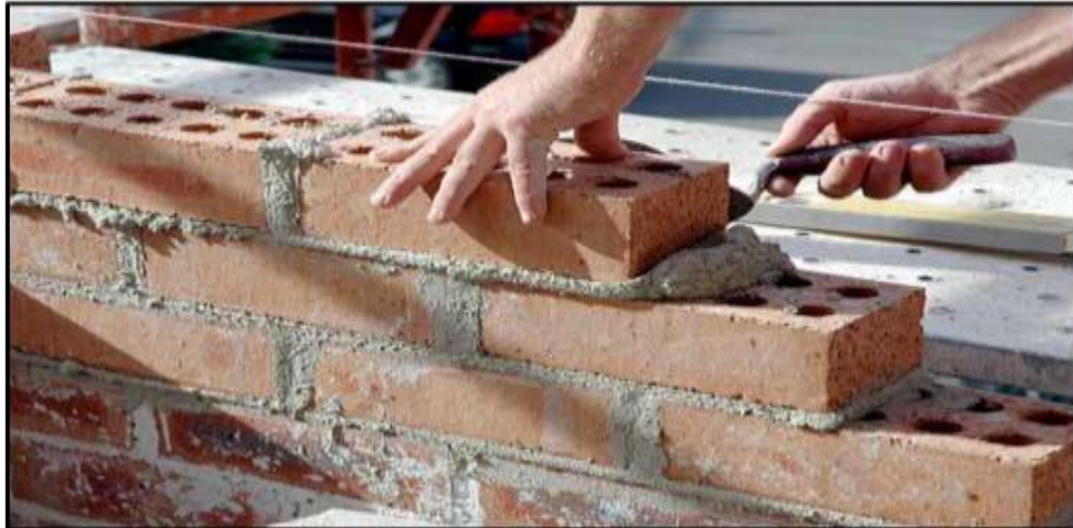
Figura 22. Unidades de Albañilería asentadas con mortero FUENTE: Imágenes Google
