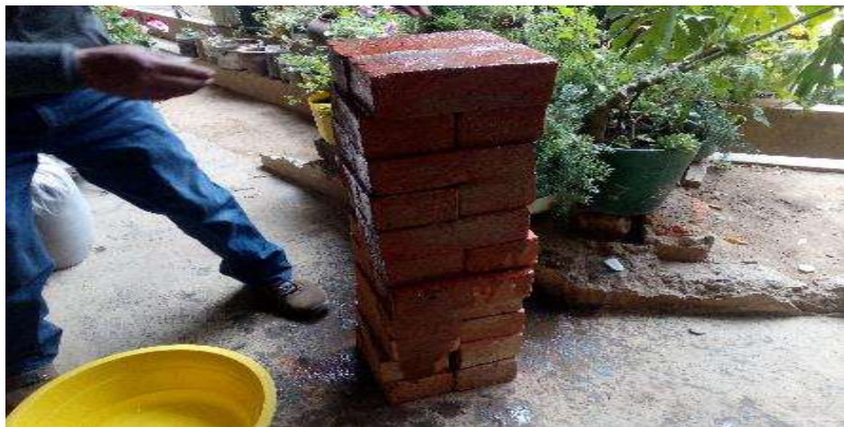
Figura 60. Hidratación de ladrillos antes de asentamiento con mortero FUENTE: Elaboración Propia
