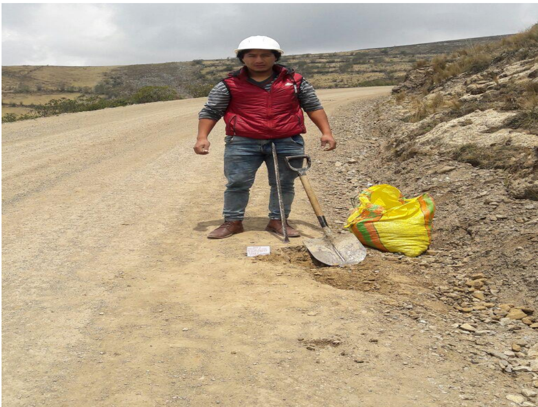
Fotografía 2. Extracción de material de la progresiva 339+150, para su análisis en laboratorio.
