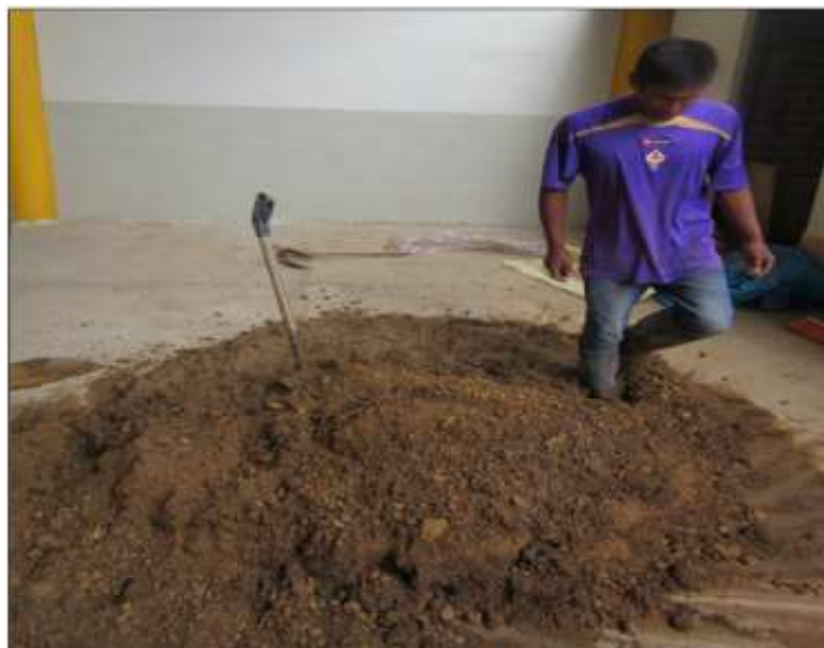
Fig. N° 3-17 Pisado de la mezcla de barro
