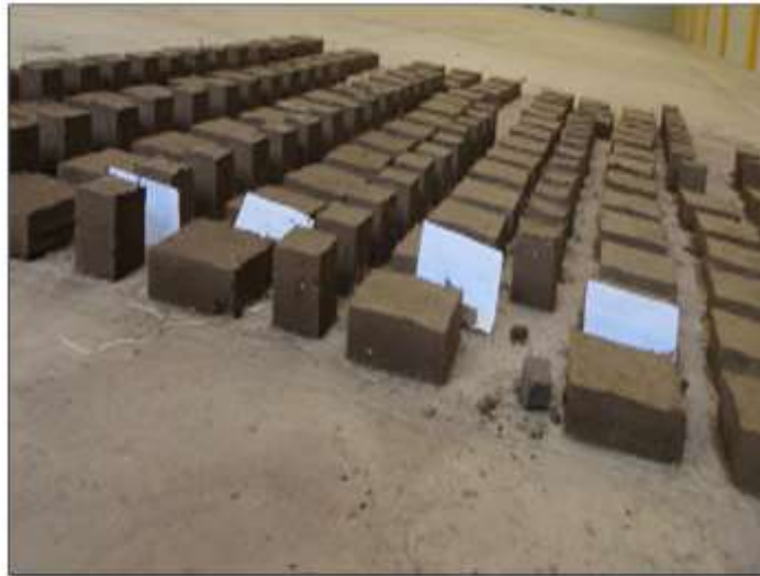
Fig. N° 3-29 Secado de adobes
