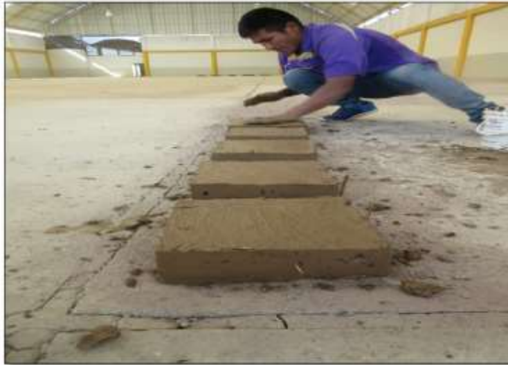
Fig. N° 3-27 Moldeado de adobe con paja
