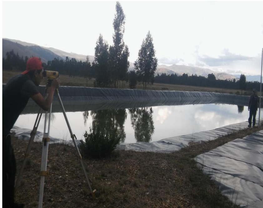
IMAGEN 1: Levantamiento topografico de la planta de tratamiento de agua residuales (Laguna de oxidacion)
