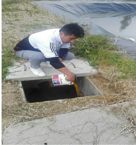
IMAGEN 19: Se aprecia que arrojamos anilina con agua a la laguna de maduración desde el inicio de este, para poder apreciar el tiempo de retención hidráulica.
