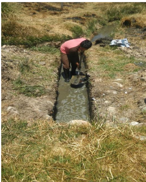
IMAGEN 7: Implementacion De Filtros Verdes - Muestras N° 2 - excavaciòn y nivelaciòn de terreno.
