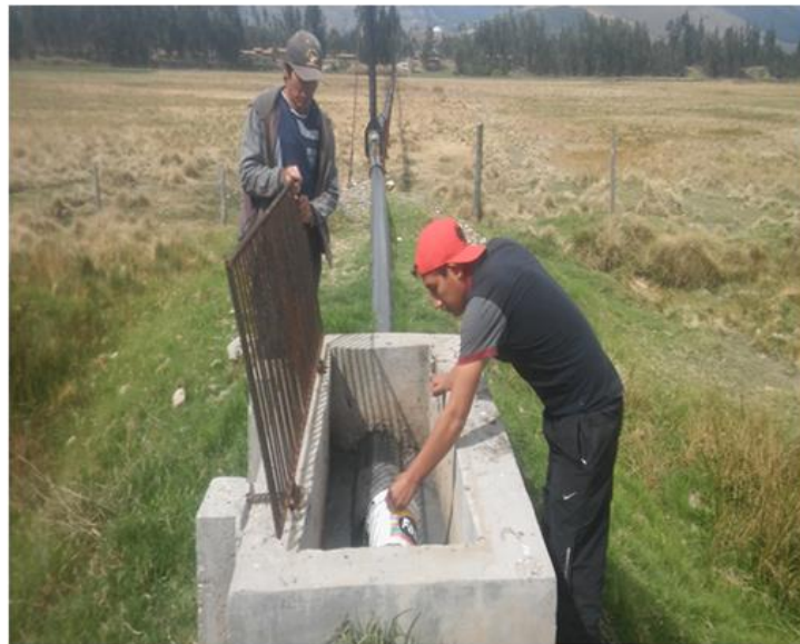
IMAGEN 15: Aforo del caudal de salida de la Planta de Tratamiento de Aguas Residuales del Centro Poblado de Yanamucllo - Matahuasi
