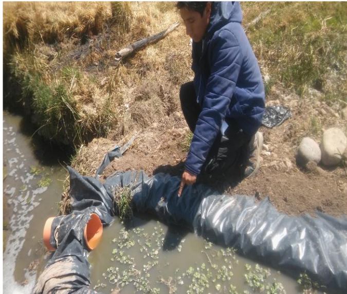
IMAGEN 10: Colocación de plantas macrófitas (berros y totoras)
