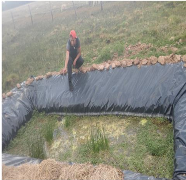
IMAGEN 5: Implementacion De Filtros Verdes N°1 - Traslado del efluente de la Laguna de Oxidación y colocación de plantas macrofitas.
