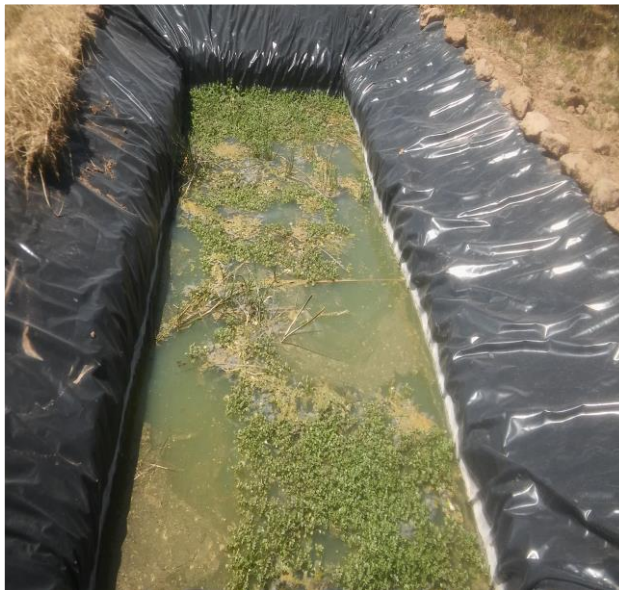
IMAGEN 4: Implementacion De Filtros Verdes N° 1 - Colocaciòn de plàstico en toda la superficie del pozo rectangular
