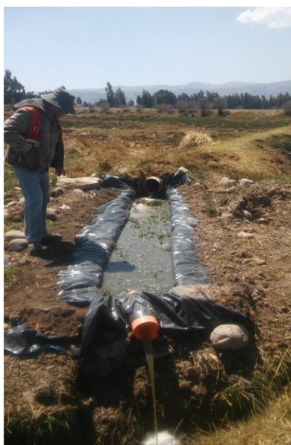
IMAGEN 8: Implementacion De Filtros Verdes N° 2 - Colocaciòn de plàstico en toda la suerficie del pozo rectangular
