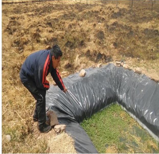
IMAGEN 5: Implementacion De Filtros Verdes N°1 - Traslado del efluente de la Laguna de Oxidación y colocación de plantas macrofitas.
