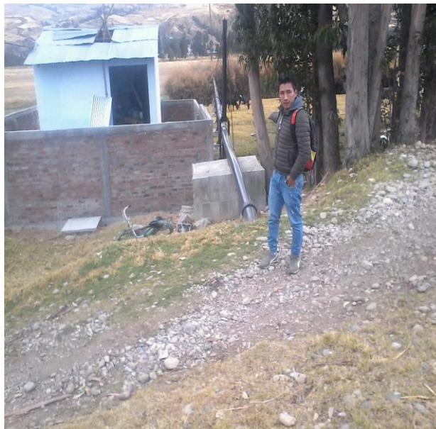
IMAGEN 20: Vista panorámica del emisor (tubería HDPE expuesto).
