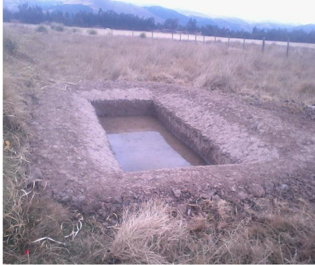
IMAGEN 3: Implementacion De Filtros Verdes - Muestra N° 1- excavaciòn y nivelaciòn de terreno.
