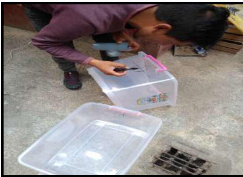
Figura 13. Medición del diámetro de entrada de la trampa de grasa.
