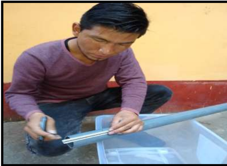
Figura 20. Medición de las longitudes de la tubería de diámetro de 2”.
