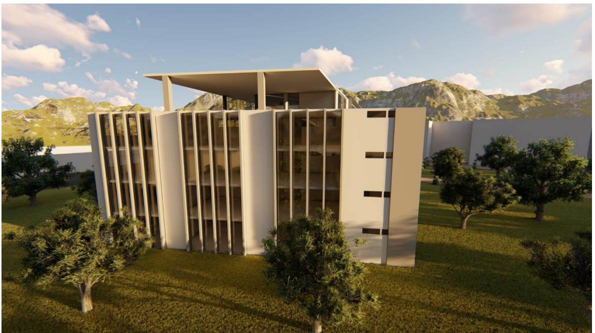
Orientación de los aleros o parasoles de las Aulas hacia el Sureste
