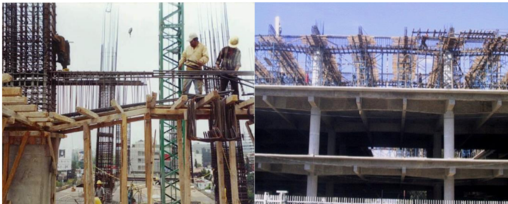
Fig. Nº 1. 2 Construcción de vigas de sección variable en dos edificios diferentes de la ciudad de México.
