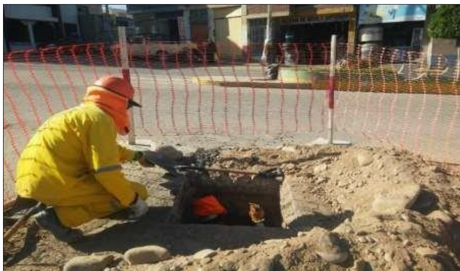
Figura N° 38: Segunda excavación de ventanas para la colocación de la abrazadera.
