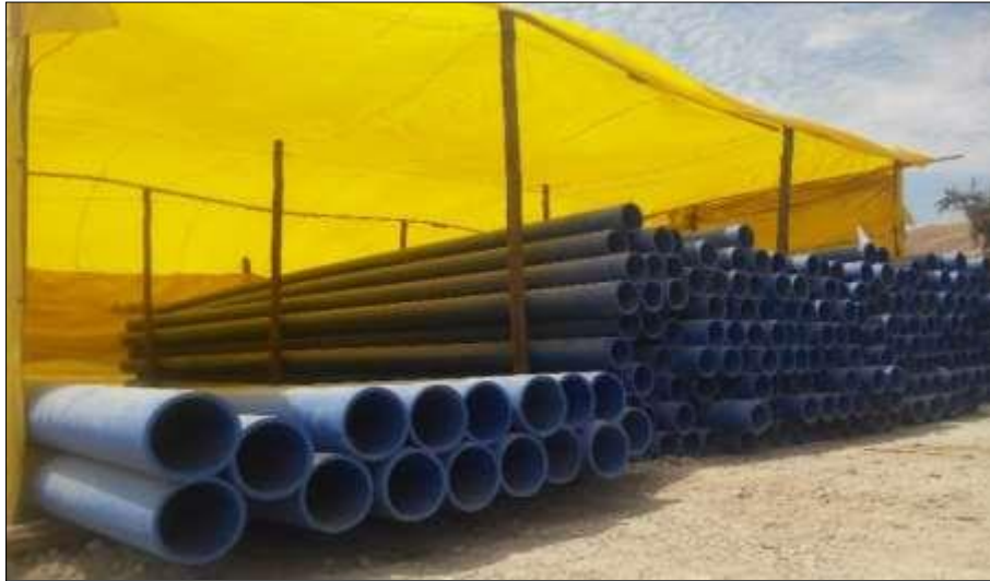
Figura N° 12: Almacén de Obra – Moquegua.
