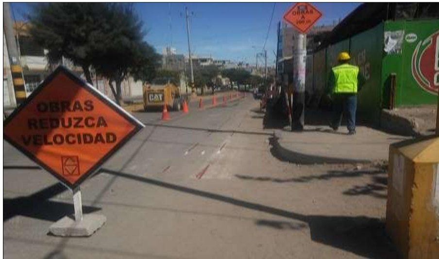
Figura N° 14: Trazo y replanteo Av. Andrés Avelino Cáceres.
