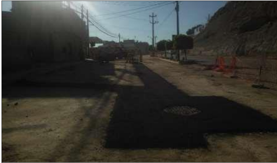
Figura N° 21: Relleno de la base de la red de alcantarillado Av. Balta – Lado derecho.
