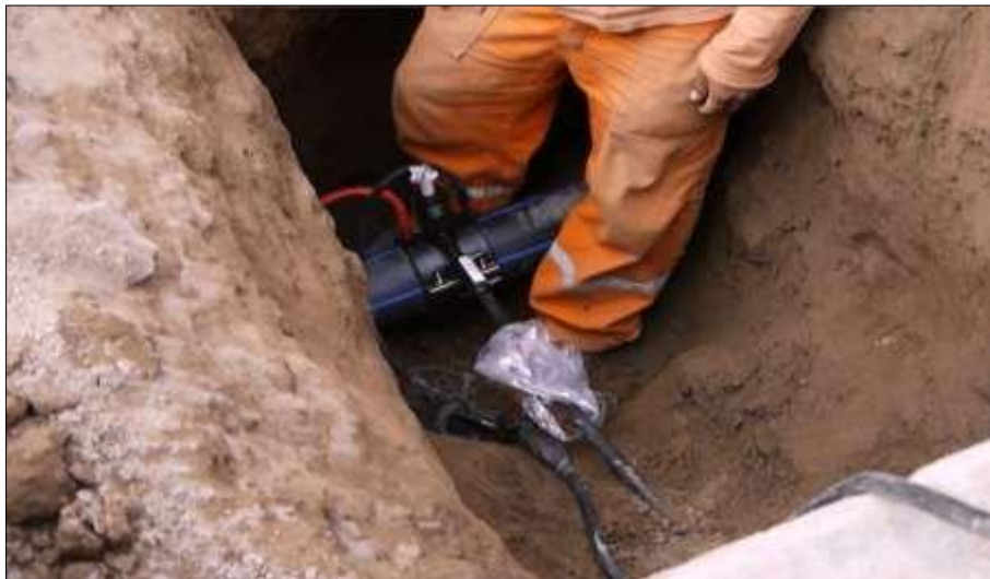
Figura N° 40: Colocación de los cables polo (+) y (-) para la electrofusión entre abrazadera tubería de la red primaria.
