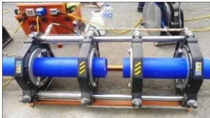
Figura N° 26: Montado de las tuberías en la máquina de termofusión.
