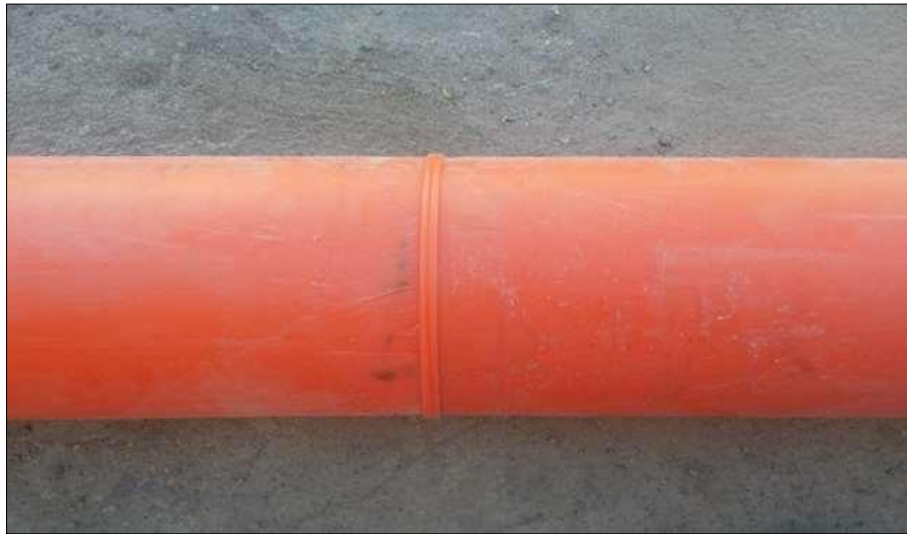
Figura N° 28: Soldadura luego del tiempo de enfriamiento – Tubería de alcantarillado.
