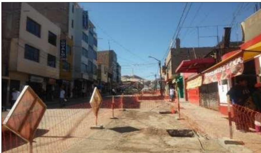
Fuente. Obra Moquegua – Moquegua (2015)
