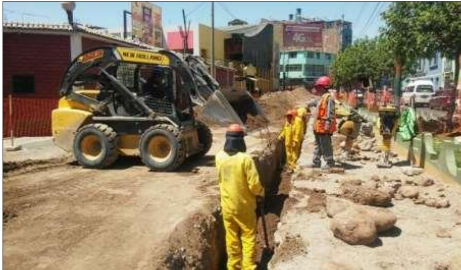
Figura N° 18: Relleno de zanja de alcantarillado Av. Balta – Lado derecho.
