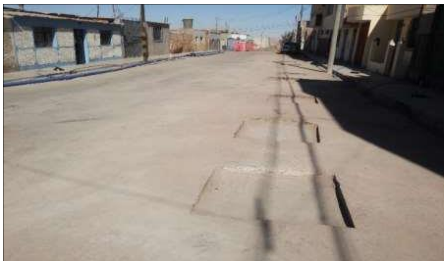
Figura N° 34: Relleno de las ventanas y reposición de pavimento.
