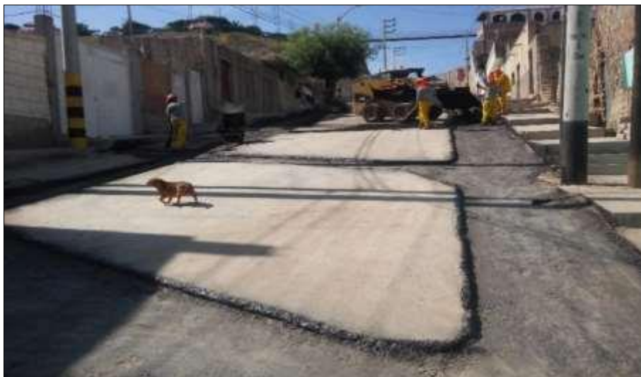
Fuente. Obra Moquegua (2015)
