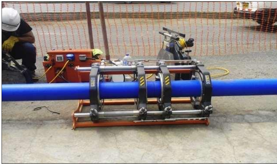
Figura N° 27: Aplicación de presión para que los tubos queden soldados.
