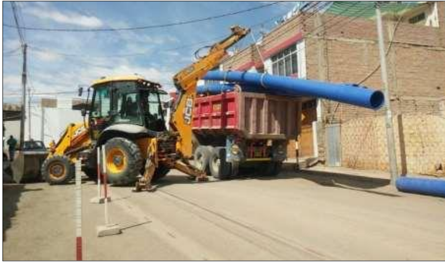
Figura N° 11: Transporte tu tubería – Obra Moquegua.
