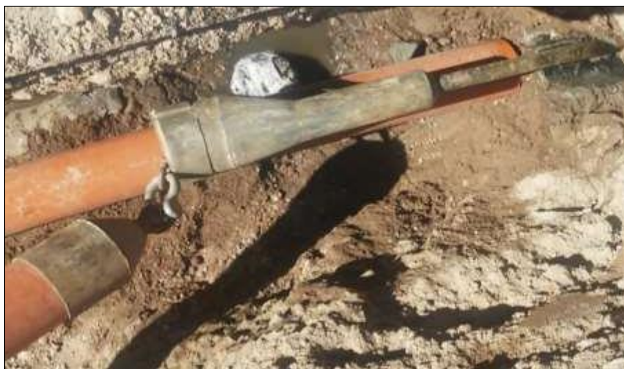
Figura N° 29: Expansor correctamente colocado en la tubería. (Ventana de entrada).
