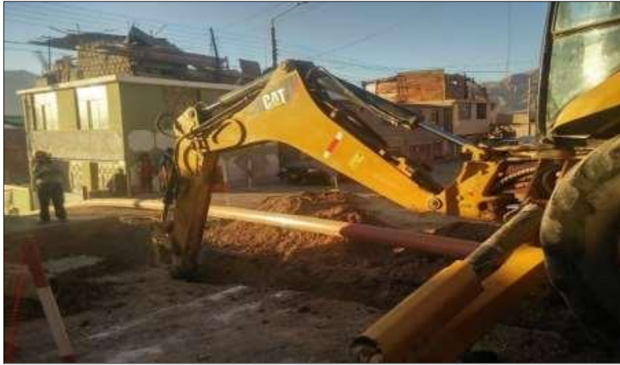
Figura N° 16: Excavación Av. Balta – lado derecho.
