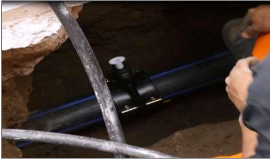
Figura N° 39: Alineación de abrazadera con la red principal.
