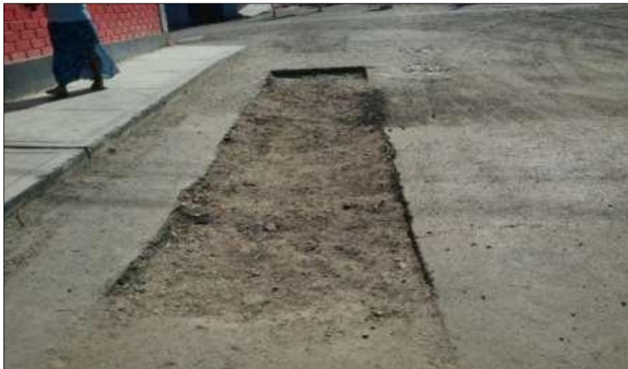
Figura N° 23: Corte y demolición de la ventana de ingreso de tubería – Ca. Ilo.
