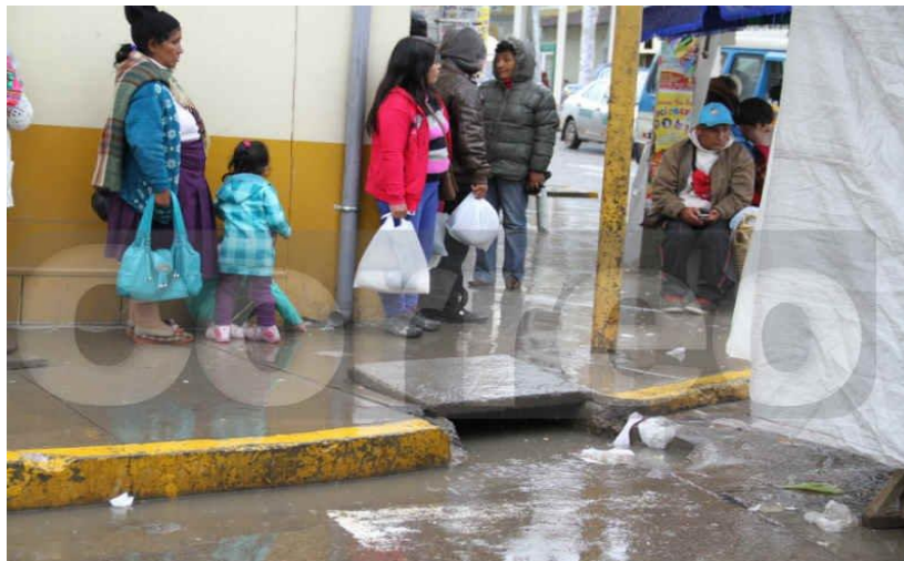
Fotografía 12. Ineficiencia del drenaje pluvial en la avenida Giráldez
