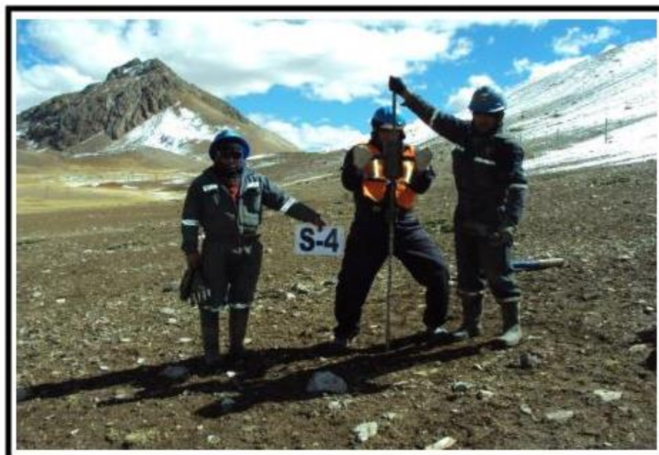
Fotografía 04 : Vista Mostrando el Sondaje (S-4), Realizado con Equipo de Penetración Dinámico (Cono de Peck) en la Cimentación de Depósito de Relaves "SANSIL" – Primera Etapa.
