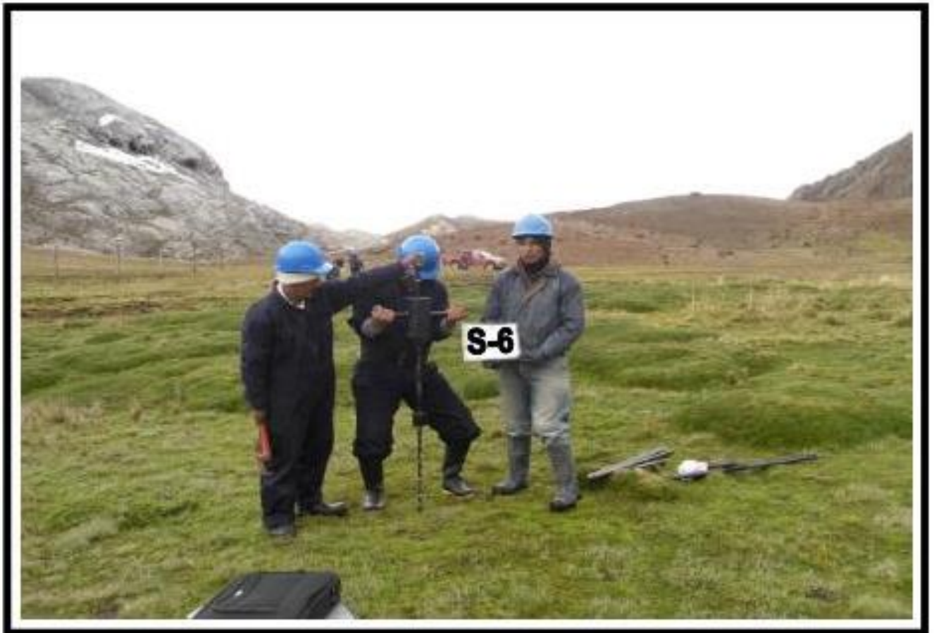
Fotografía 07 : Vista Mostrando el Sondaje (S-6), Realizado con Equipo de Penetración Dinámico (Cono de Peck) en la Cimentación de Depósito de Relaves "SANSIL" - Primera Etapa.
