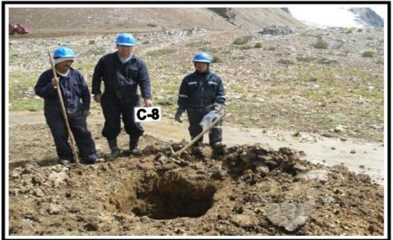
Fotografía 10 : Vista Exterior de la Calicata (C-8), Realizada en la Cimentación del Dique del Depósito de Relaves "SANSIL" – Primera Etapa. Se Puede Apreciar el Material Excavado Constituido por Suelo Coluvial que Clasifica como Grava Limosa con Arena (GM).
