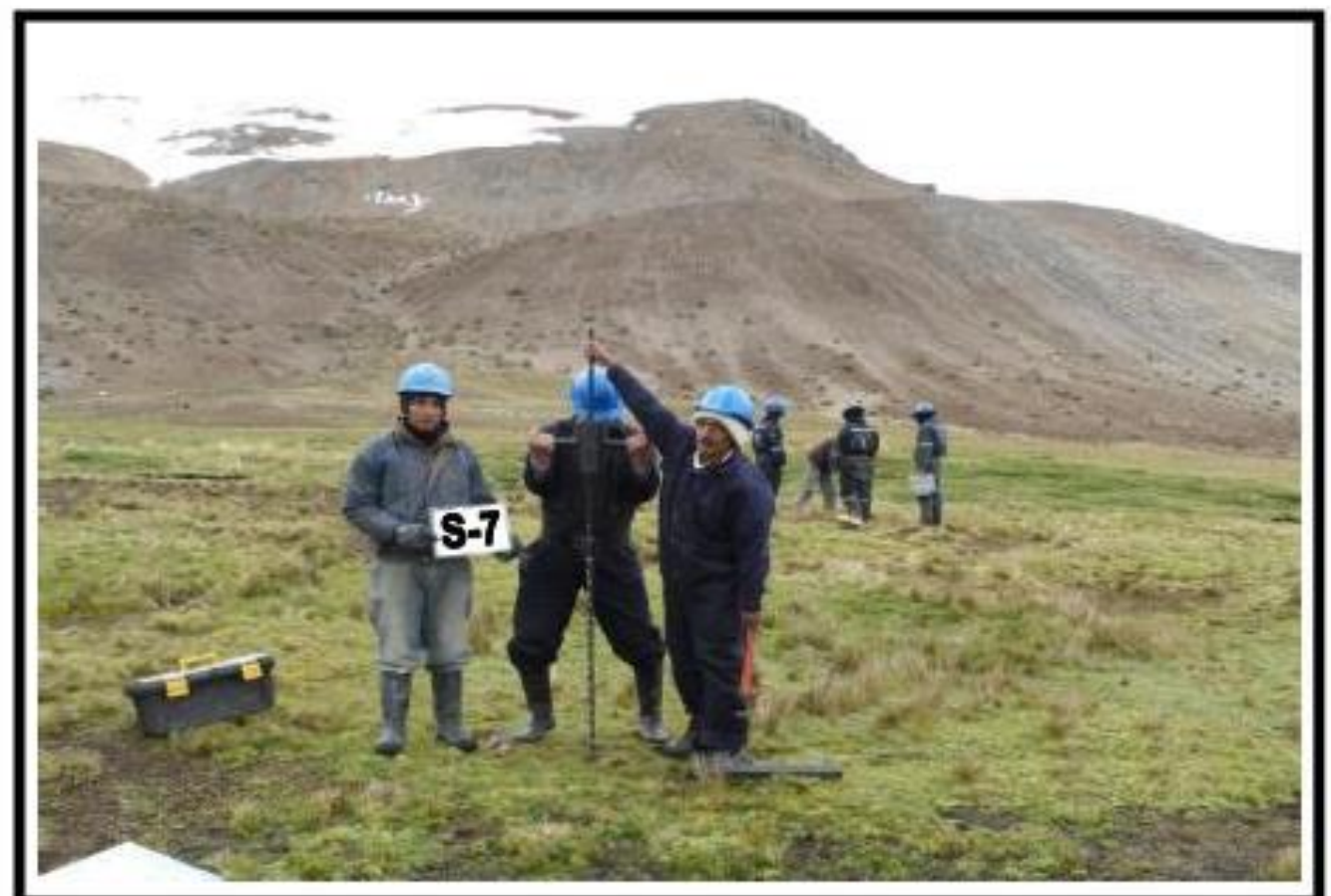
Fotografía 08 : Vista Mostrando el Sondaje (S-7), Realizado con Equipo de Penetración Dinámico (Cono de Peck) en la Cimentación de Depósito de Relaves "SANSIL" – Primera Etapa.
