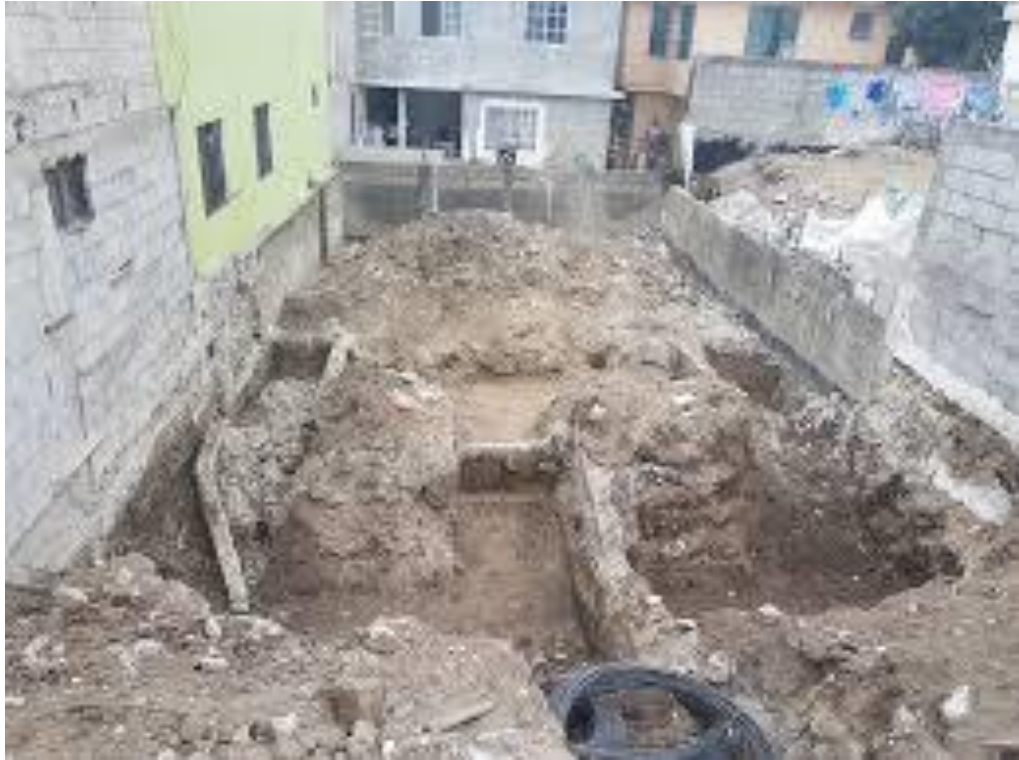
Limpieza del terreno
