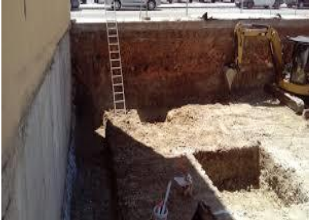
Escabacion delas sanjas para la cimentacion
