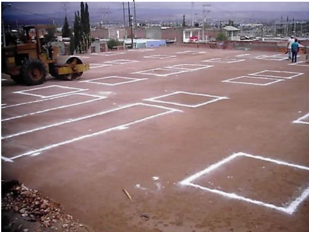
Replanteo en el terreno de la cimentacion
