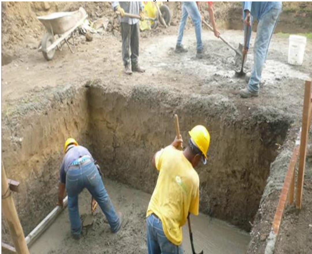
Cimentacion de las zapatas
