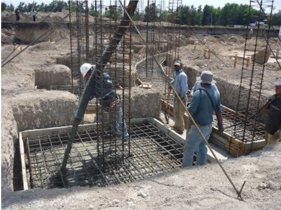
Colocacion del acero de las columnas
