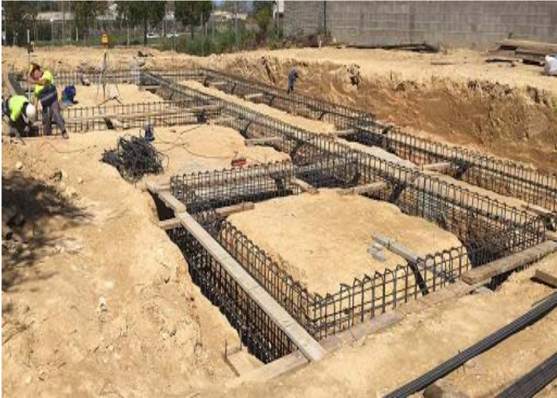
Colocacion del acero de la cimentacion
