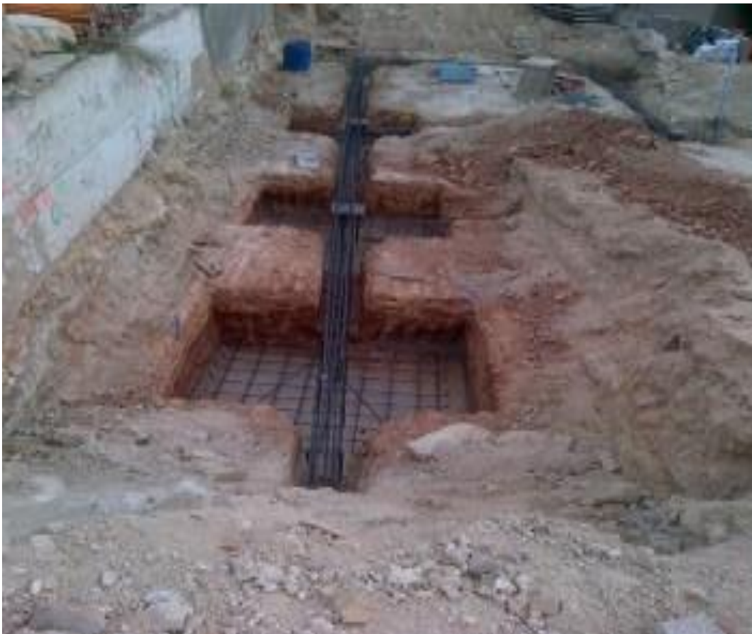
Colocacion del acero de la cimentacion
