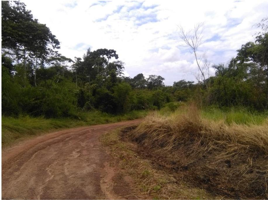
Figura 26:Erosión de la subrasante por escorrentía.
