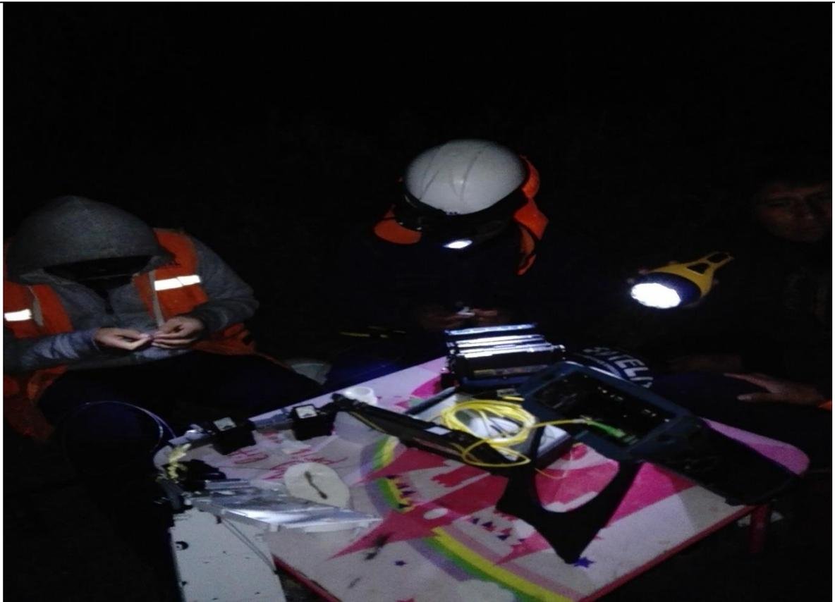
**Fotografía N° 7. Fusión y medición de hilos de fibra óptica en horario nocturno.**
