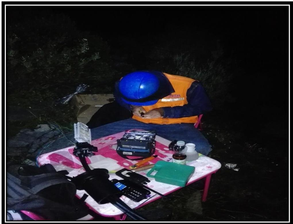
**Gráfico 74.** *Fusión de hilos de fibra óptica en un cierre de empalme.*
