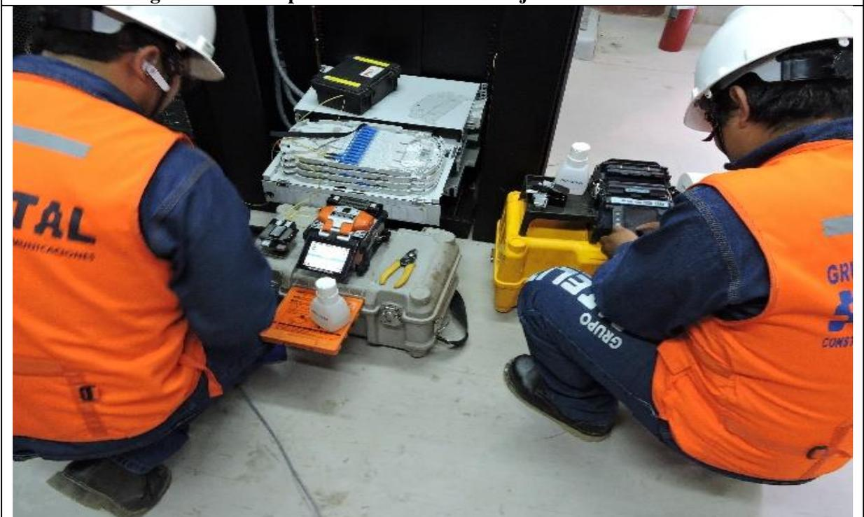
**Fotografía N° 2. Fusión de hilos de fibra óptica en los sites claro.**
