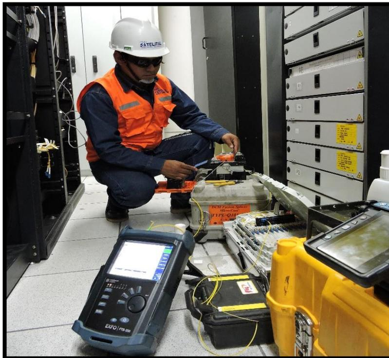
**Gráfico 73.** *Medición de hilos de fibra óptica de la red de América Móvil.*
