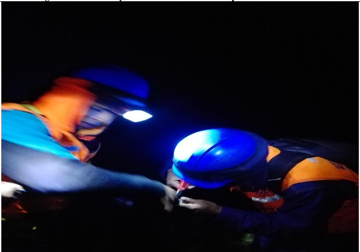
**Fotografía N° 8. Acondicionamiento de caja de cierre de empalme en horario nocturno.**
