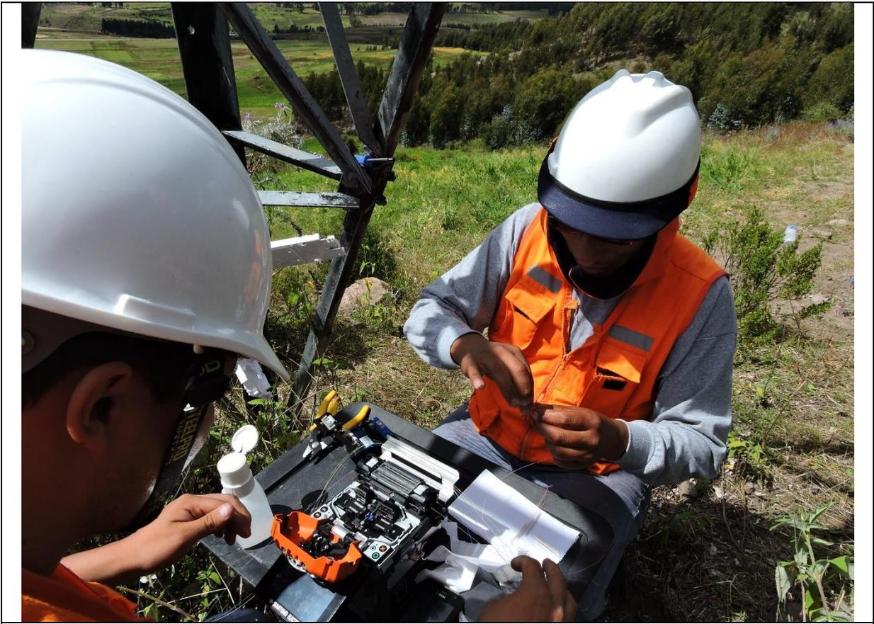
**Fotografía N° 3. Fusión de hilos de fibra óptica en los cierre de empalme.**
