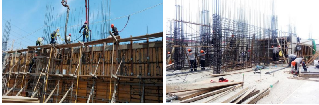
Figura 16 : Imágenes de Trabajos Productivos (Vaciado De Concreto) EJE F –PL 02 y colocación de acero
