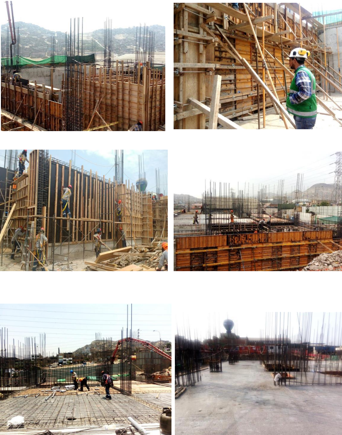
Figura 10 Fotos actuales de obra (antes de la aplicación lean construction)
