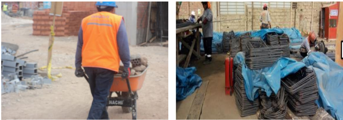
Figura 17 : Imágenes de Trabajos contributorios (habilitado de acero) y cargado de material y/o limpieza
