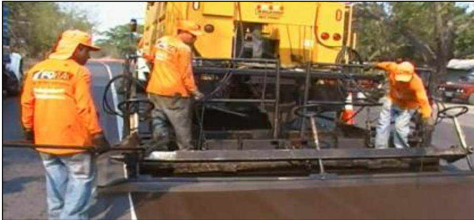
Figura 9. Aplicación de Slurry Seal. Fuente: (Orellana, Mauricio; Peña, Edgar; Perez, Blanca, 2015) (1)
