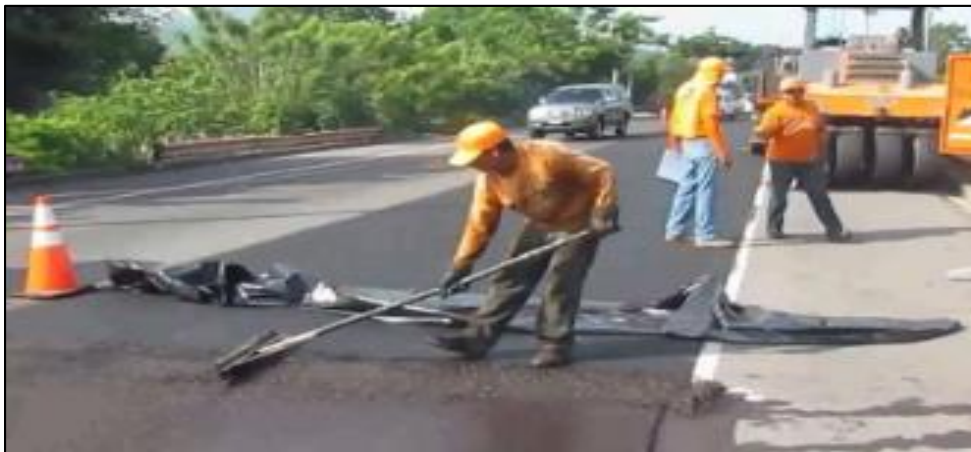
Figura 10. Corrección de imperfecciones en juntas. Fuente: (Orellana, Mauricio; Peña, Edgar; Perez, Blanca, 2015) (1)
