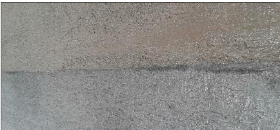
Figura 11. Junta de un Slurry Seal previa y post ruptura. Fuente: (Orellana, Mauricio; Peña, Edgar; Perez, Blanca, 2015) (1)
