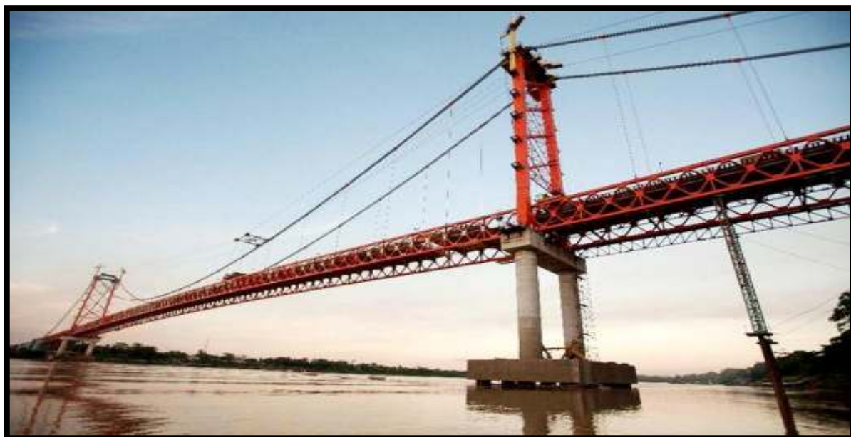
FIGURA N° 2.5: Viga de rigidez del puente continental, ubicado en Puerto Maldonado, que une Perú-Brasil, Fabricado por la empresa Austriaca, Waagner Biro, de luz central de torre a torre 320m.
