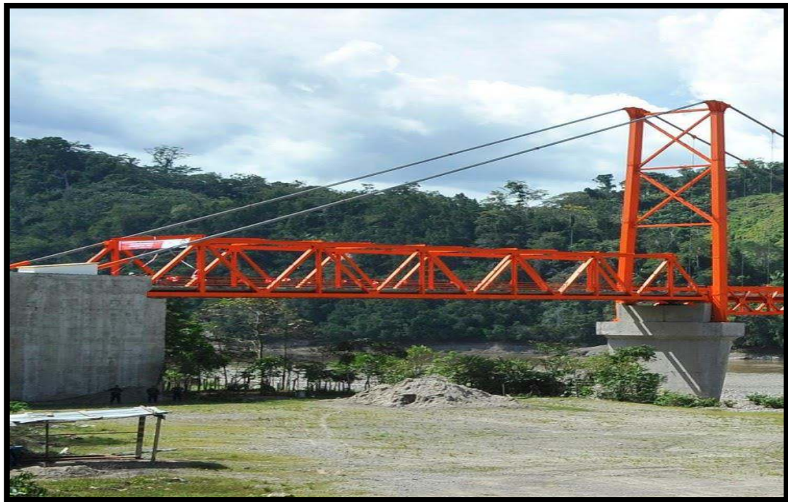
FIGURA N° 2.15: Torre con riostra en cruz, puente colgante Fabricado por la empresa Austriaca Waagner Biro, Punta arenas, ubicado en la provincia mariscal Cáceres, Región san Martin.
