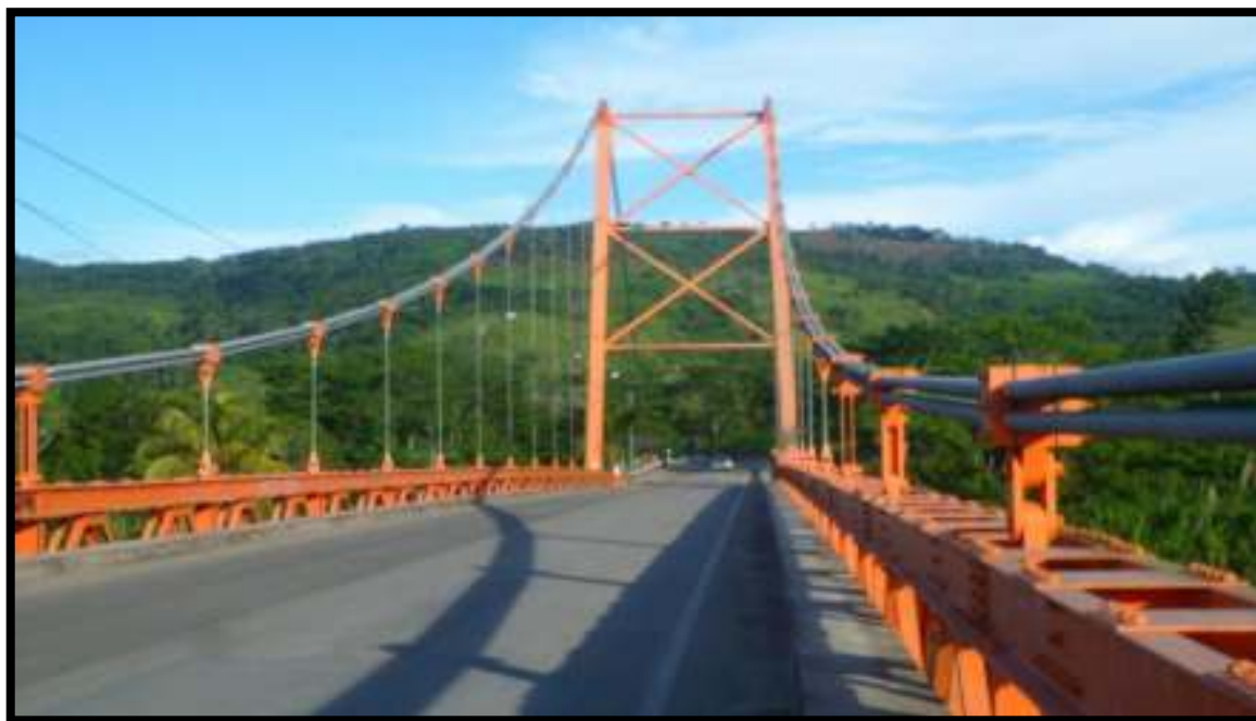
FIGURA N° 2.2: Puente Colgante Tocache, Sobre el rio Huallaga, procedente de Austria fabricado por la empresa Waagner Biro.
