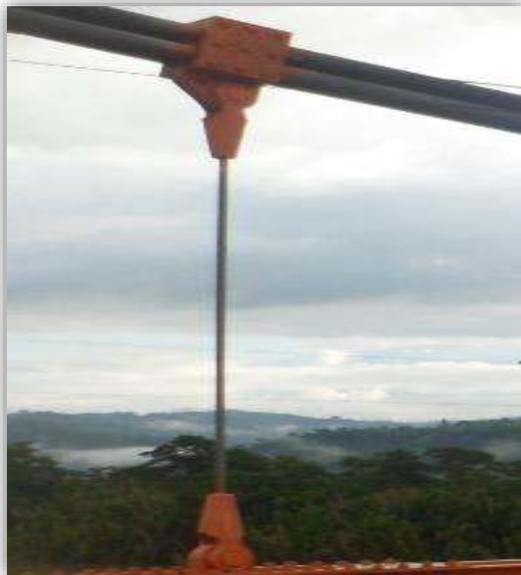
FIGURA N° 2.12: Péndola formado por un cable, puente colgante Fabricado por la empresa Austriaca, Waagner Biro, sobre el rio Huallaga en la provincia de Tocache, región San Martin.
