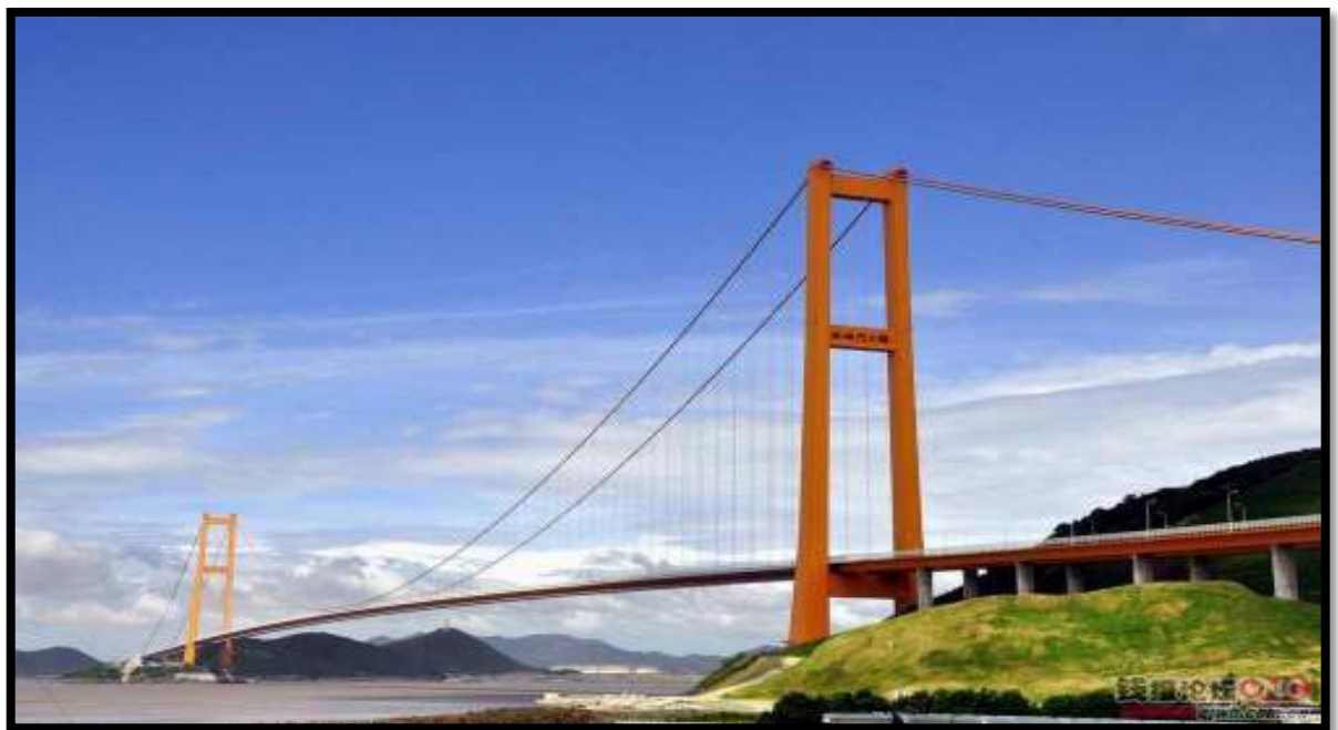
FIGURA N° 2.7: Puente colgante Xihoumen, ubicado en la provincia de Zhejiang China, con luz de torre a torre 1650m.
