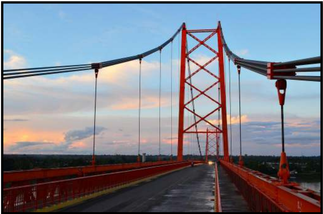
FIGURA N° 2.14: Torre con riostra en cruz, puente colgante Fabricado por la empresa Austriaca Waagner Biro, Ubicado en puerto Maldonado, que une Perú-Brasil.
