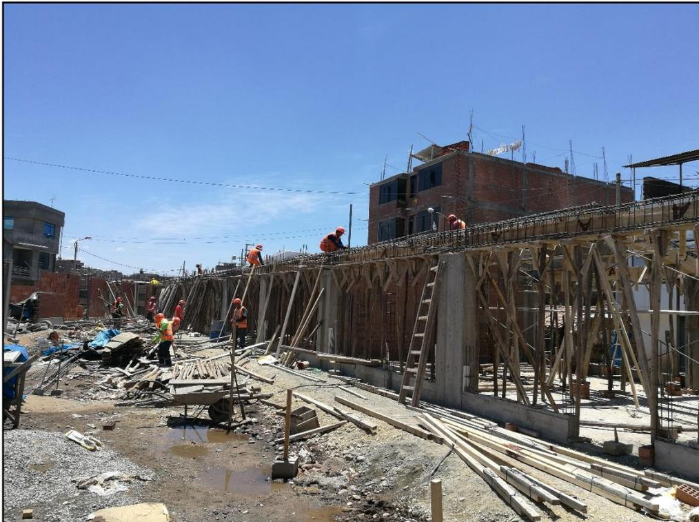
FOTO N°20: ENCOFRADO DE VIGAS DE MODULO 01 Y 02.
