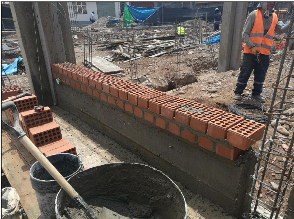
FOTO N°16: ASENTADO DE LADRILLO DE CABEZA EN MUROS PORTANTES.
