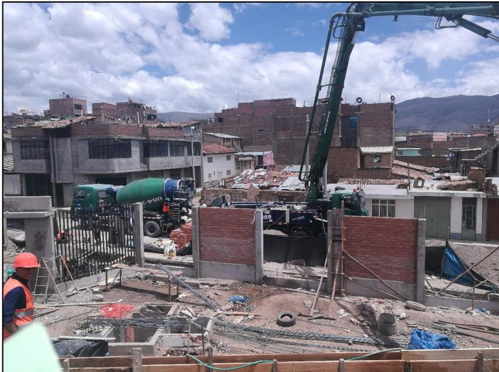
FOTO N°25: VACIADO DE LOSA ALIGERADA DE MODULO 01 Y 02.
