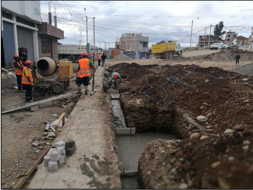
FOTO N°03: PREPARACION DE CONCRETO PARA SOLADO PROPORCION 1:10 C:H E=010M DE ZAPATAS Y VIGAS DE CIMENTACION.
