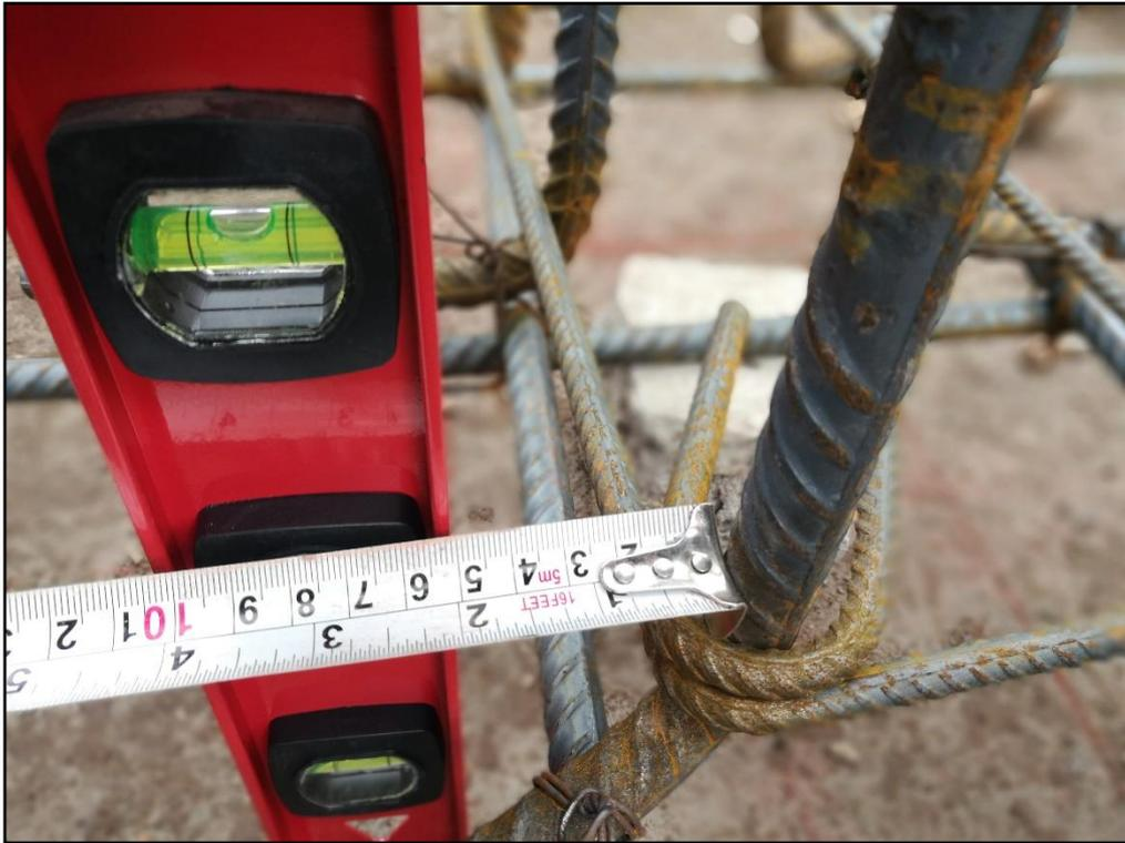
FOTO N°07: VERIFICACION DE ALINEAMIENTO Y RECUBRIMIENTO DE COLUMNAS DE LOS MODULOS 01 Y 02.
