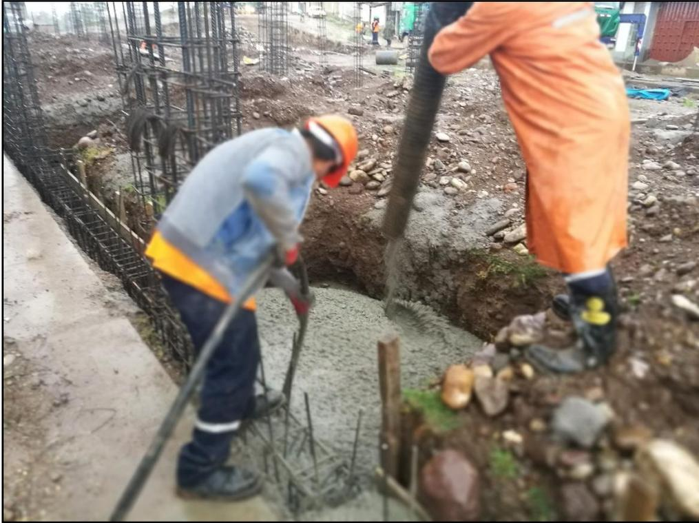
FOTO N°13: VACIADO DE ZAPATAS MODULO 01 Y 02 CONCRETO
