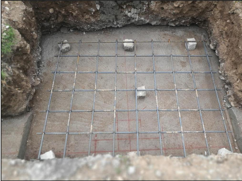
FOTO N°05: COLOCAION DE ACERO EN ZAPATAS CON SUS REPECTIVOS
