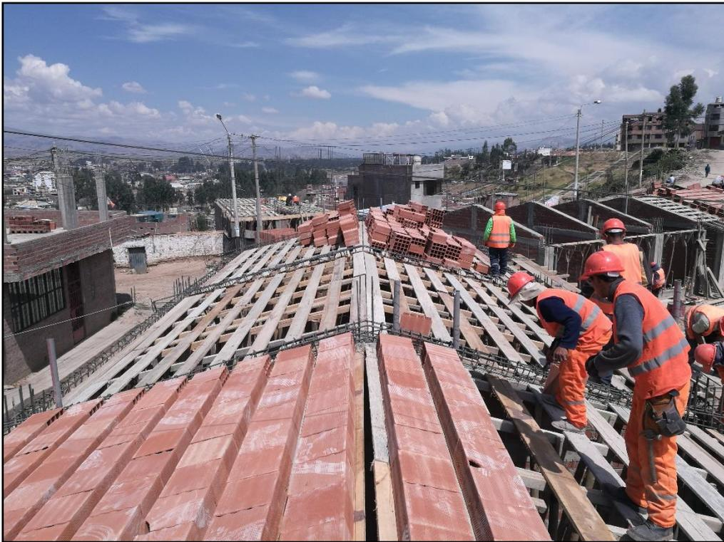
FOTO N°23: ENCOFRADO DE LOSA ALIGERADA DE MODULO 01 Y 02.
