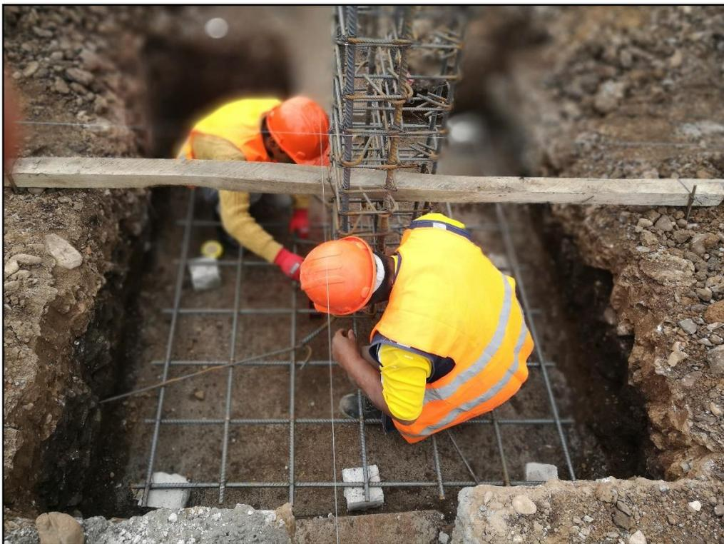
FOTO N°08: VERIFICACION DE ALINEAMIENTO Y RECUBRIMIENTO DE COLUMNAS DE LOS MODULOS 01 Y 02.
