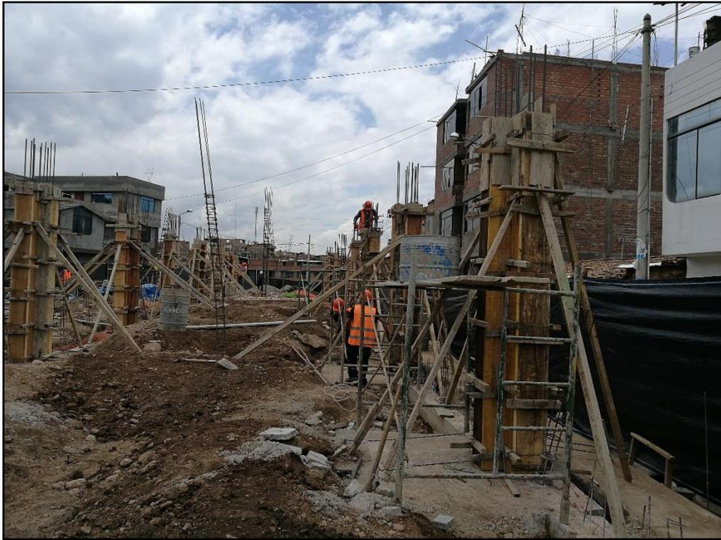
FOTO N°15: VACIADO DE COLUMNAS MODULO 01 Y 02 CONCRETO
