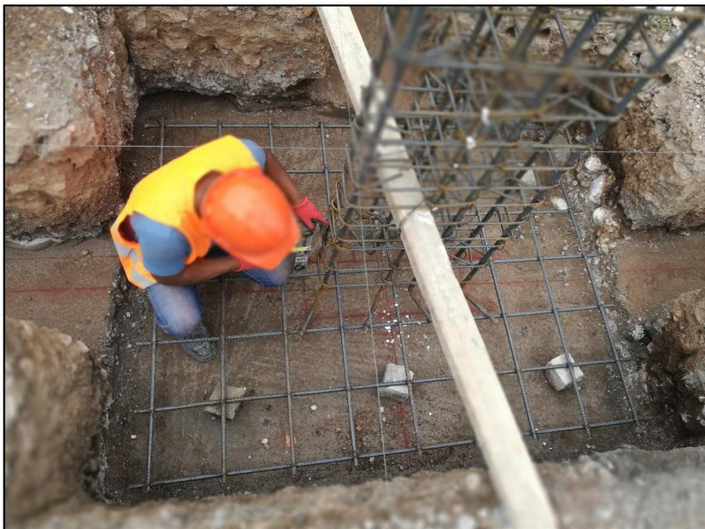
FOTO N°06: VERIFICACION DE ALINEAMIENTO Y RECUBRIMIENTO DE
