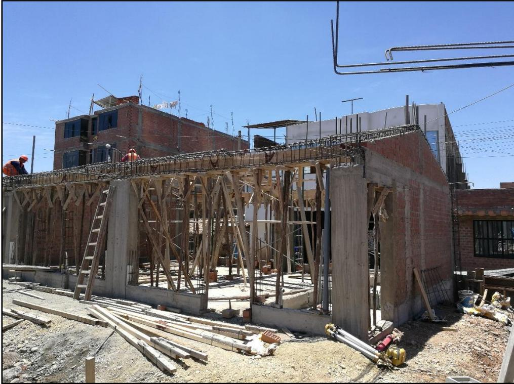
FOTO N°21: ENCOFRADO DE VIGAS DE MODULO 01 Y 02.
