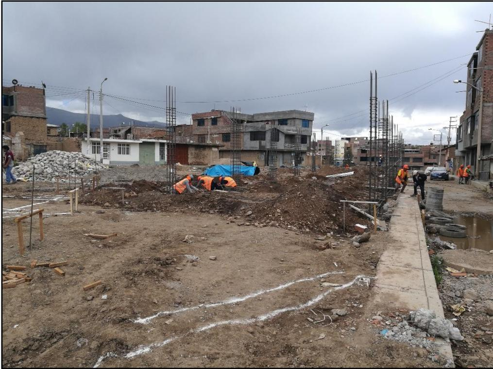
FOTO N°09: IZADO DE COLUMNAS DE LOS MODULOS 01 Y 02.
