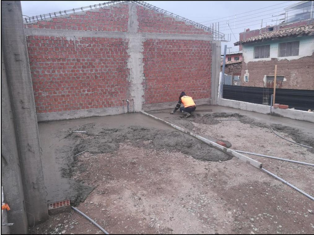
FOTO N°19: VACIADO DE FALSO PISO CONCRETO FC=175 KG/CM2.
