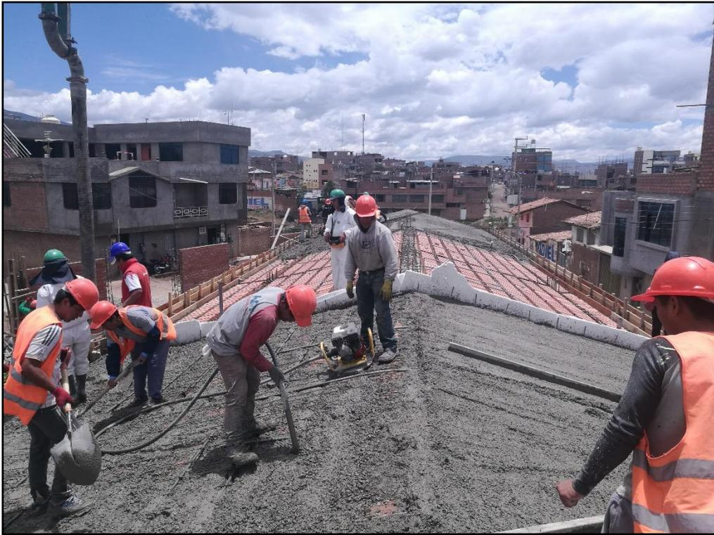
FOTO N°26: VACIADO DE LOSA ALIGERADA DE MODULO 01 Y 02.
