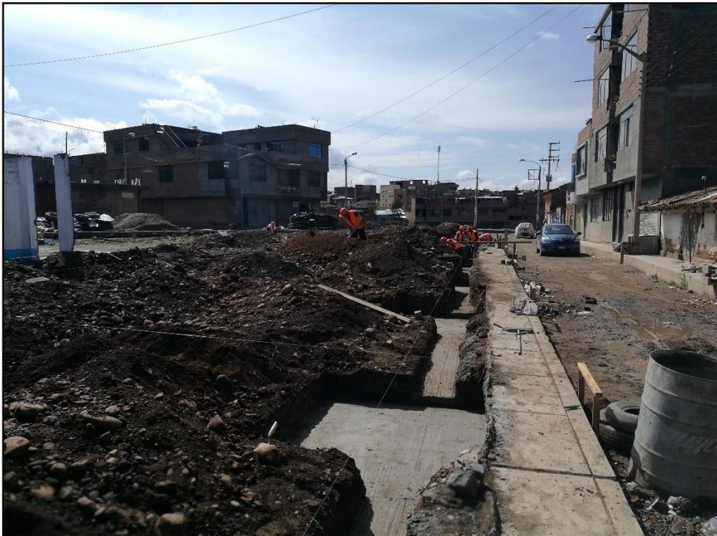
FOTO N°04: SOLADO DE ZAPATAS Y VIGAS DE CIMENTACIÓN.
