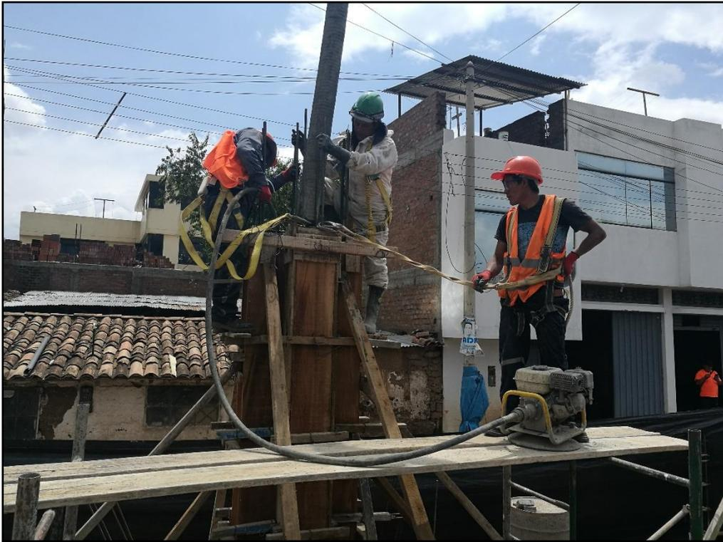
FOTO N°15: VACIADO DE COLUMNAS DE MODULO 01 Y 02 CONCRETO PREMEZCLADO FC=210 KG/CM2
