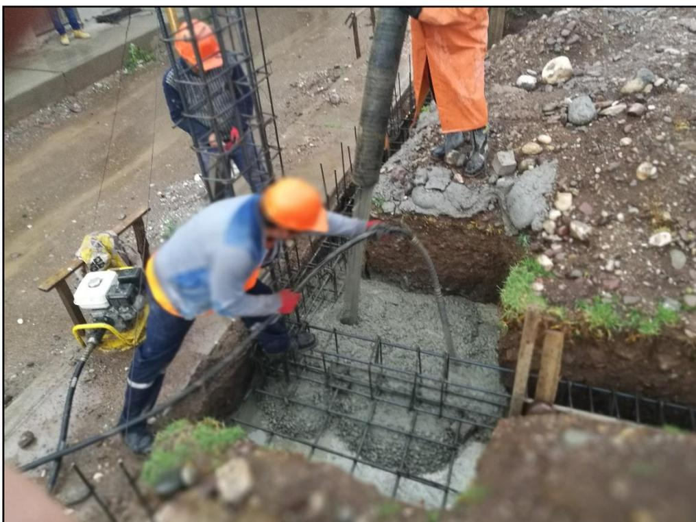
FOTO N°12: VACIADO DE ZAPATAS MODULO 01 Y 02 CONCRETO PREMEZCLADO FC=210KG/CM2.
