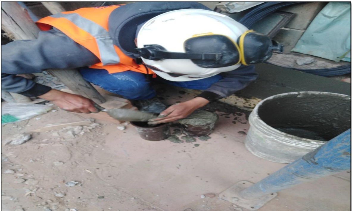
Fotografía 22. Se observa el llenado de las probetas de 4" x 8" que posteriormente fueron llevados al laboratorio para ser sometidas a compresión.
