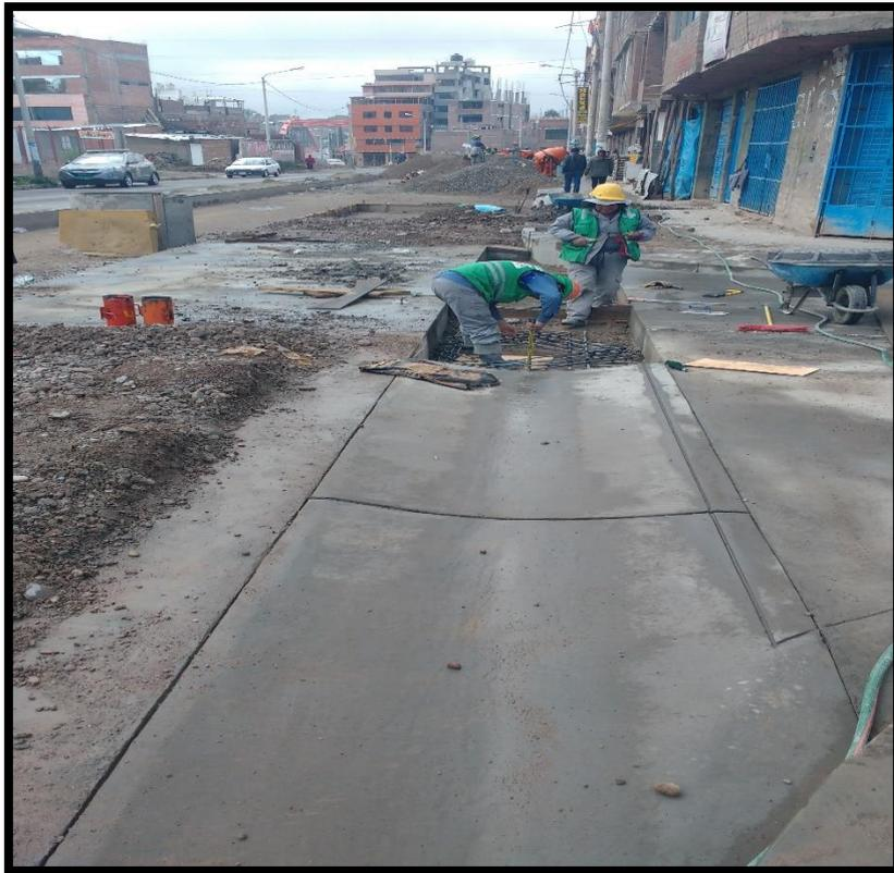
Fotografía 8. Anotando el rendimiento de encofrado de baden
