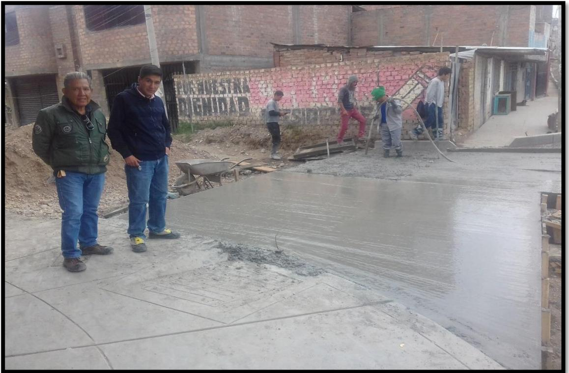
Fotografía 12. Anotando el rendimiento de concreto en bocacalle
