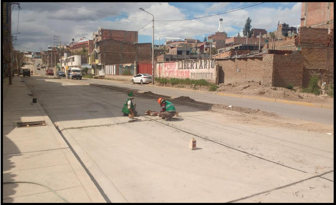
Fotografía 17. Anotando el rendimiento de relleno de juntas.
