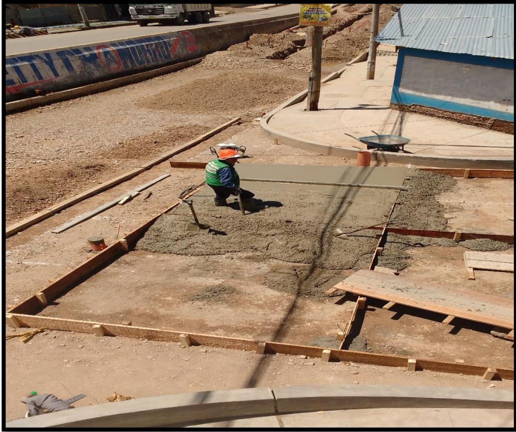
Fotografía 9. Anotando el rendimiento de concreto en baden.
