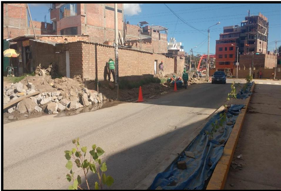
Fotografía 2. demolición de sumideros y estructuras de concreto.
