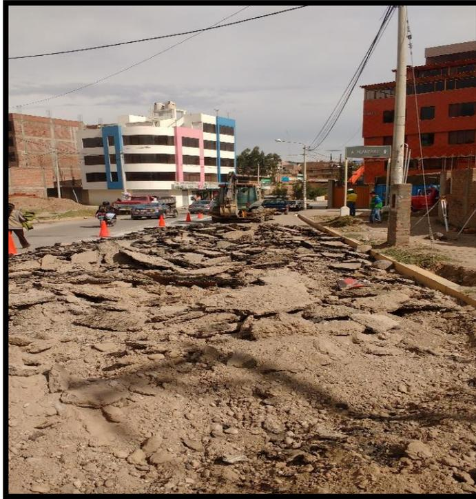
Fotografía 1. midiendo la demolición de pavimento existente.
