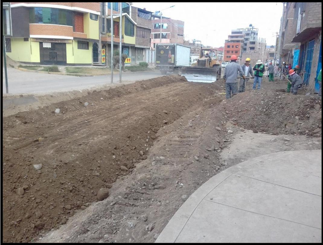
Fotografía 3. Anotando el rendimiento de corte de terreno.
