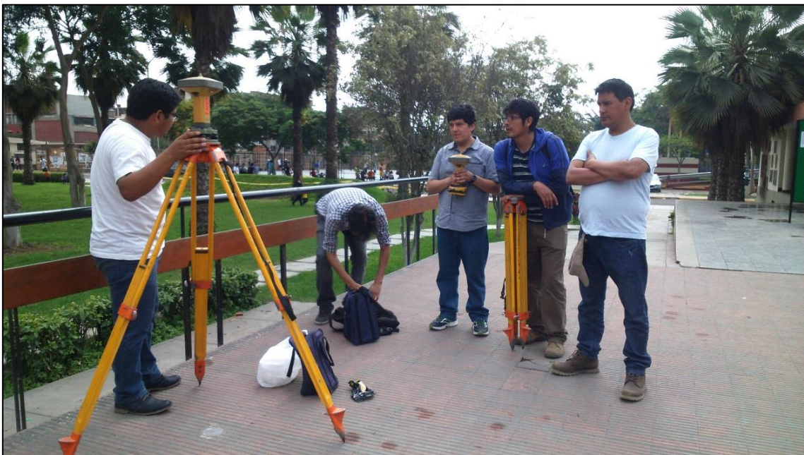
colocación de punto de control
