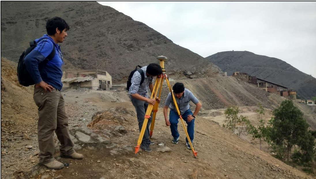
Colocación de punto de control
