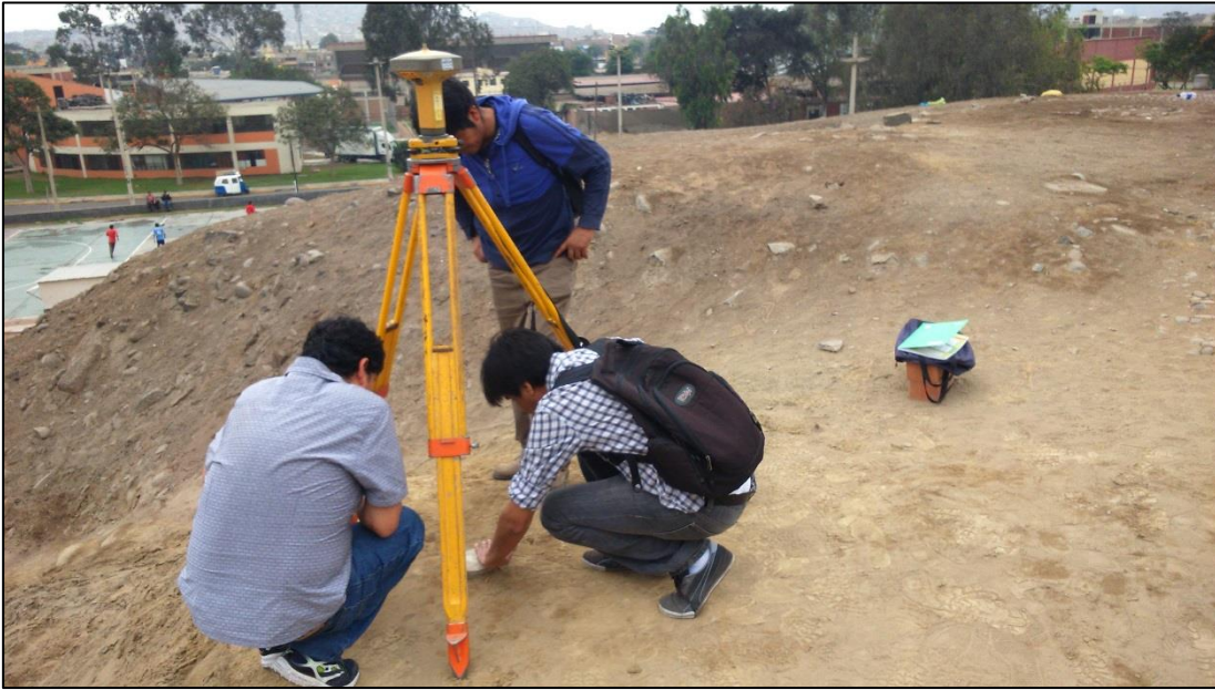
Colocación de punto de control con estación RTK GPS, marca TOPCON, Modelo GR3
