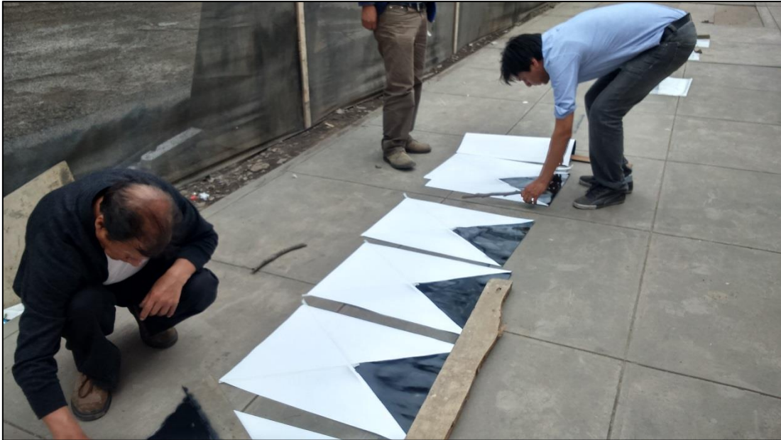
Elaboración de marcas para puntos de control
