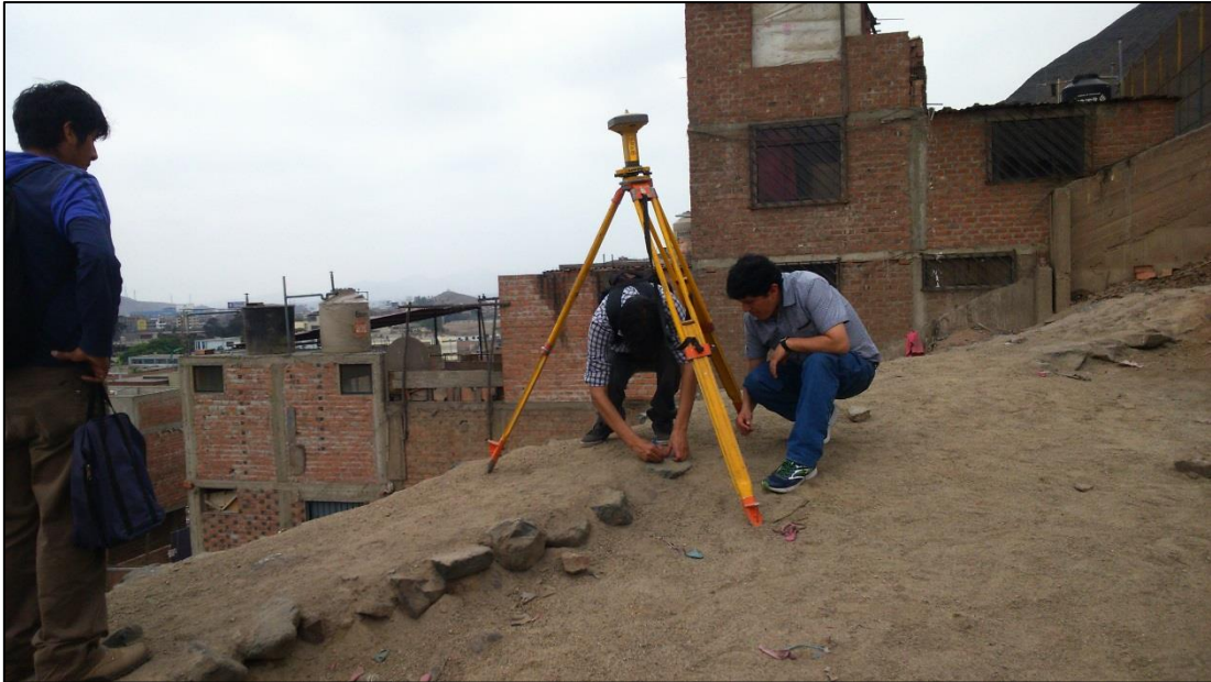
Colocación de punto de control
