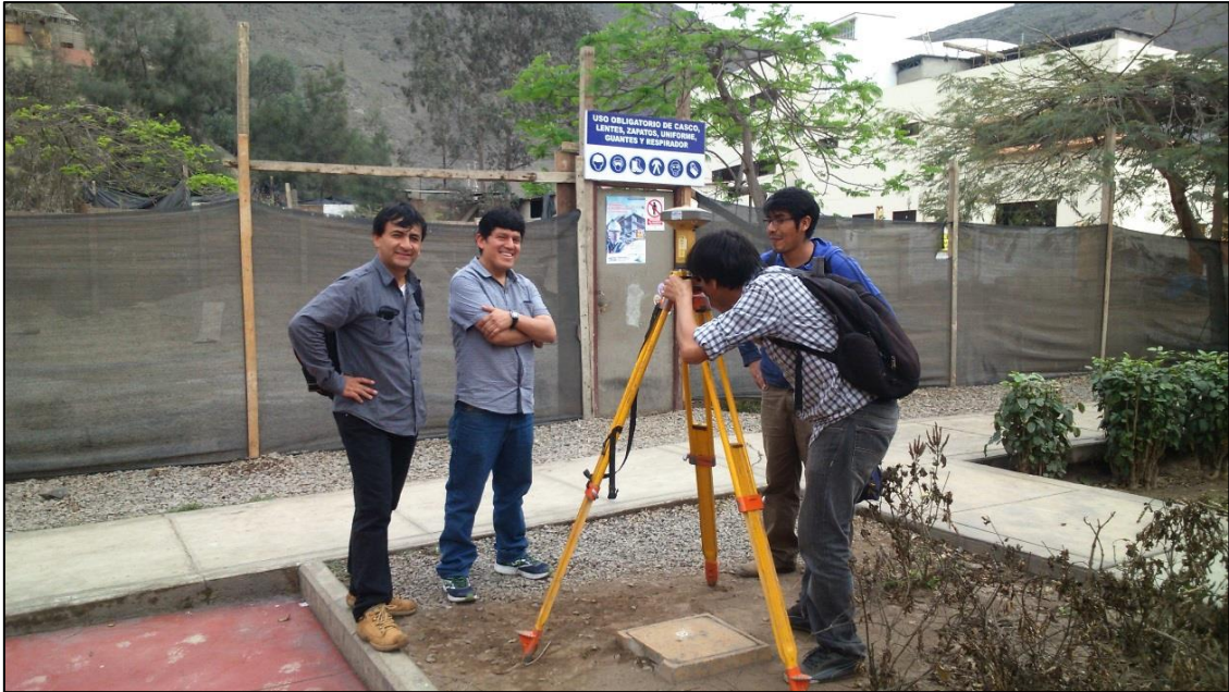
Colocación de punto de control
