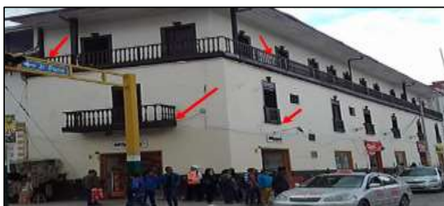
Figura 4.6: Vista de balcones y parapetos
