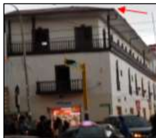
Figura 4.5: Vista de techo a dos aguas típica
