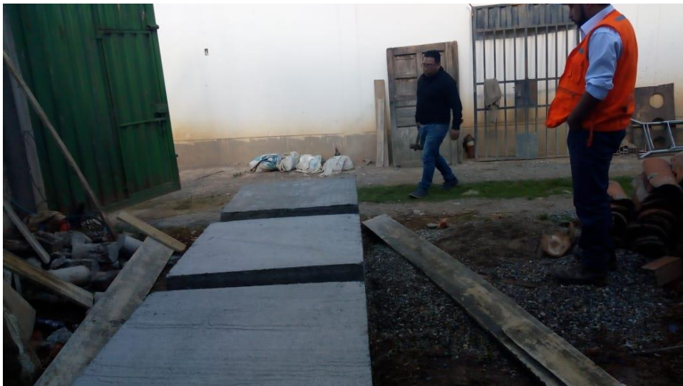
Fotografía 23. Vista de la losa aligerada convencional, con adición de jugo y fibra de maguey.
