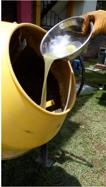
Fotografía 6. Mezclado del concreto con adición de jugo de maguey.
