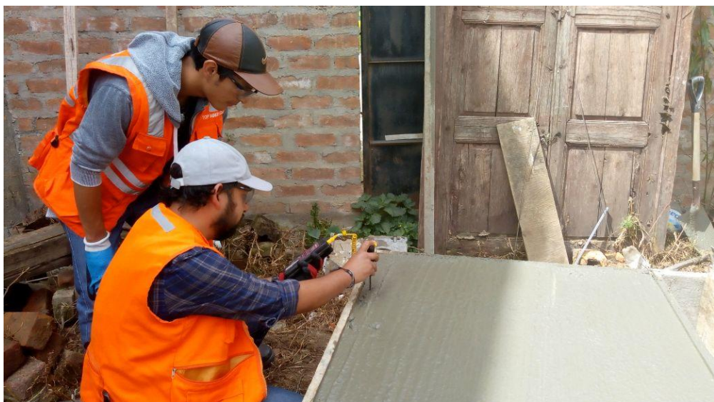
Fotografía 21. Medición de la temperatura en las losas aligeradas.
