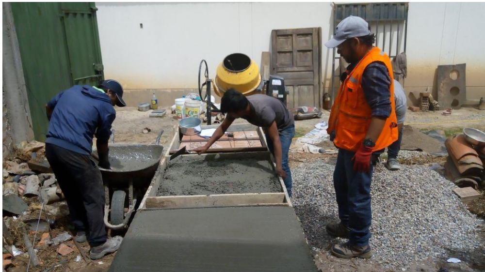
Fotografía 19 y Fotografía 20. Vaciado de losas aligeradas.
