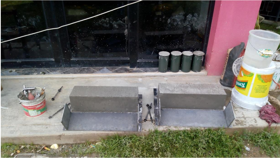
Fotografía 14. Desencofrado de vigas.
