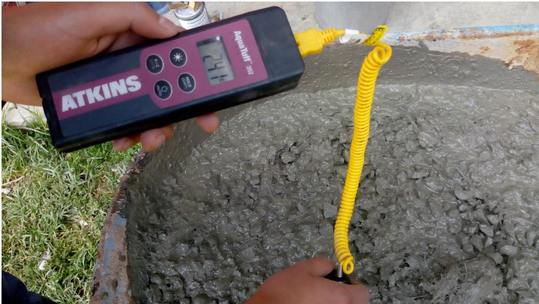
Fotografía 8. Medición de la temperatura en el concreto.
