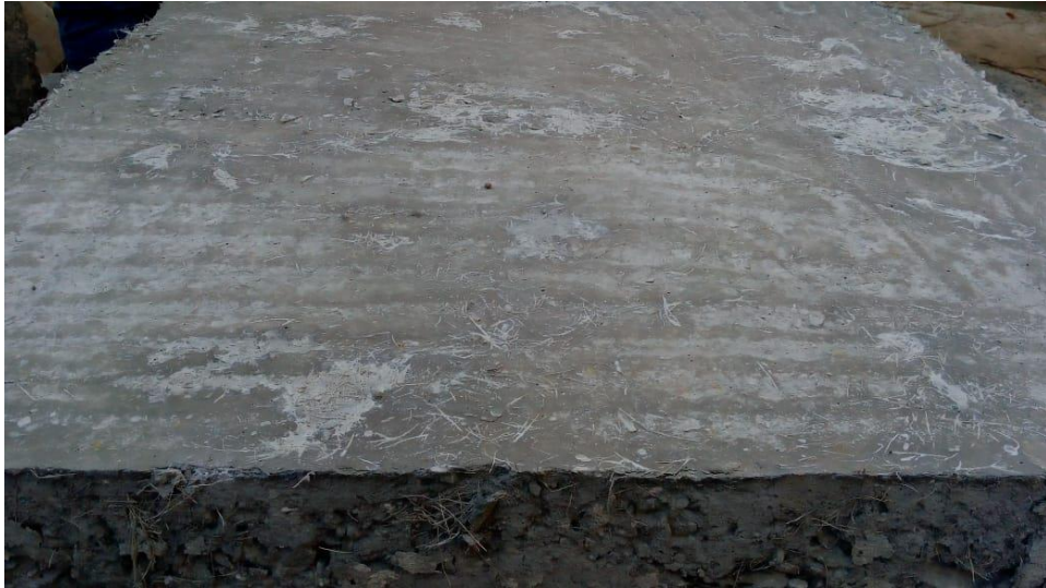
Fotografía 22. Losa aligerada con adición de fibra de maguey.
