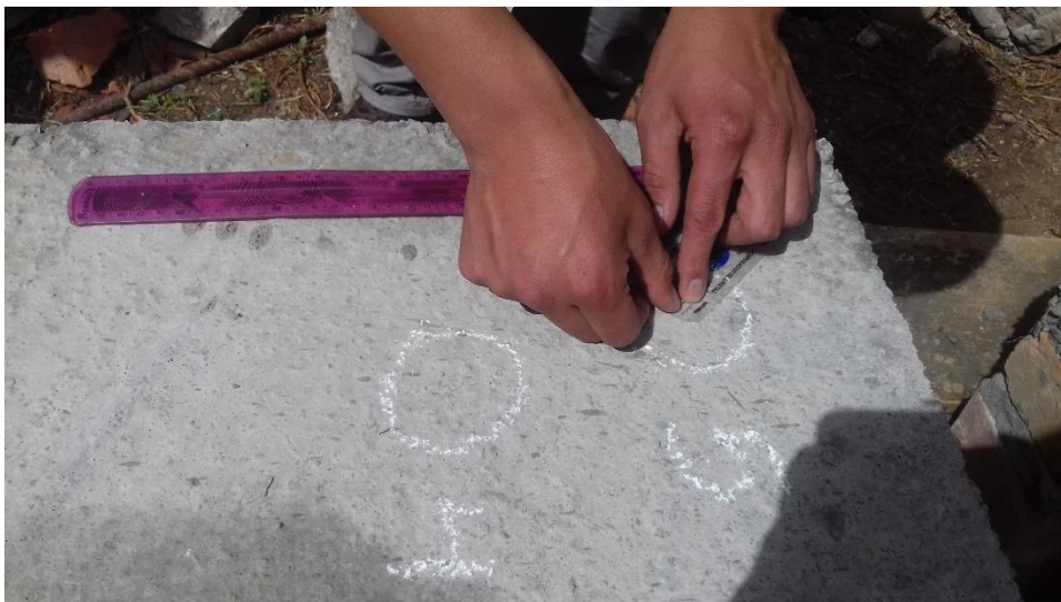
Fotografía 26. Medición de la fisura N° 4 y 5 en la losa aligerada convencional.
