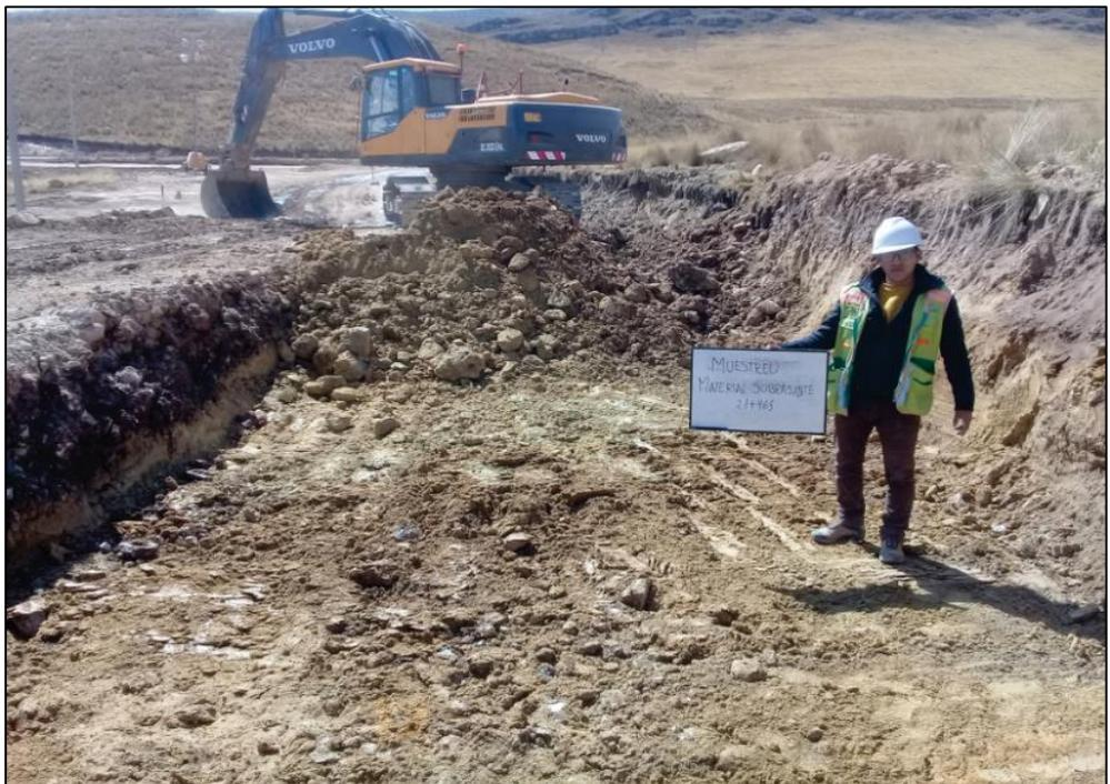
*Figura 32: Calicata 02 - Muestreo de material de Subrasante Km: 21+465.00*
