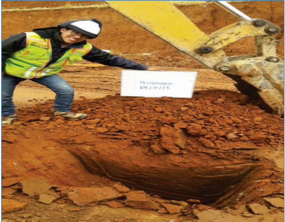
*Figura 31: Calicata 01 - Muestreo de material de Subrasante Km: 21+465.00*
