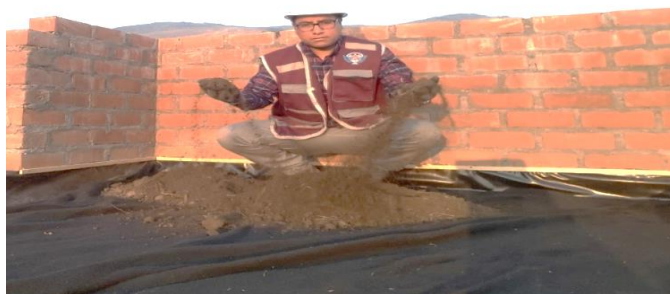
Figura 71 Instalación de Estrato Fuente: Elaboración Propia
