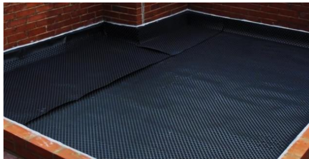
Figura 68 Instalación de Geomembrana Fuente: Elaboración Propia
