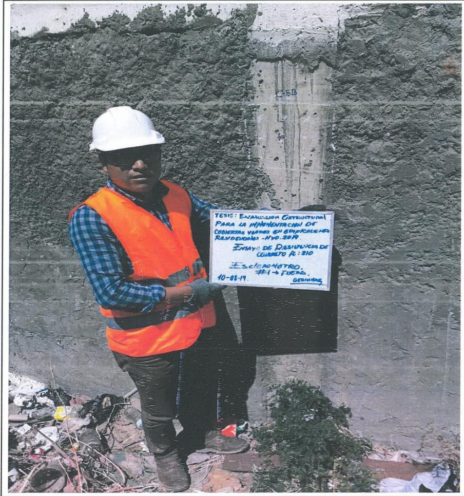
FOTO 02.- ENSAYO DE ESCLEROMETRIA, " EVALUACION ESTRUCTURAL EN EDIFICACIONES RESIDENCIALES PARA LA IMPLEMENTACION DE CUBIERTAS VERDES EN LA CIUDAD DE HUANCAYO"- RESIDENCIAL VARO JR LOS ROSALES N°251
