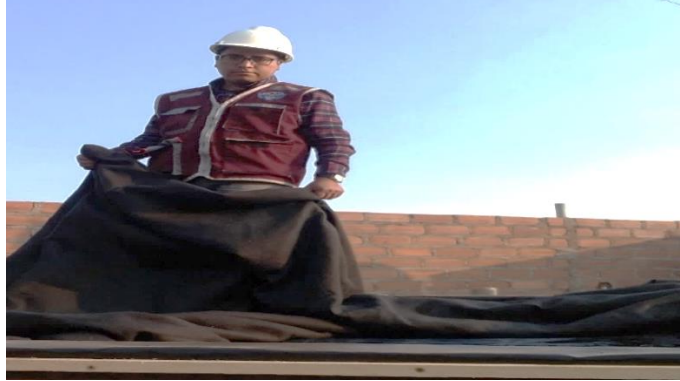
Figura 69 Instalación de capa Filtrante – Geotextil Fuente: Elaboración Propia
