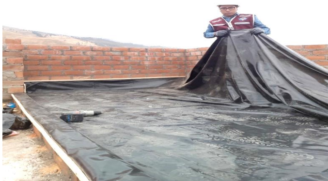
Figura 65 Impermeabilización del área Fuente: Elaboración Propia
