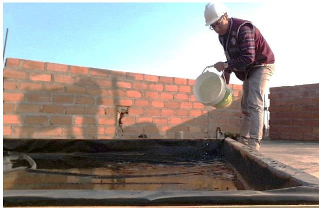
Figura 67 Prueba de Estanquidad Fuente: Elaboración Propia
