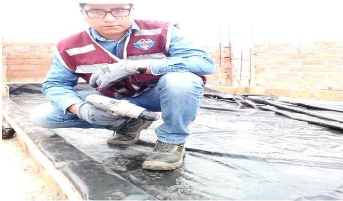
Figura 66 Actividad de Impermeabilización Fuente: Elaboración Propia
