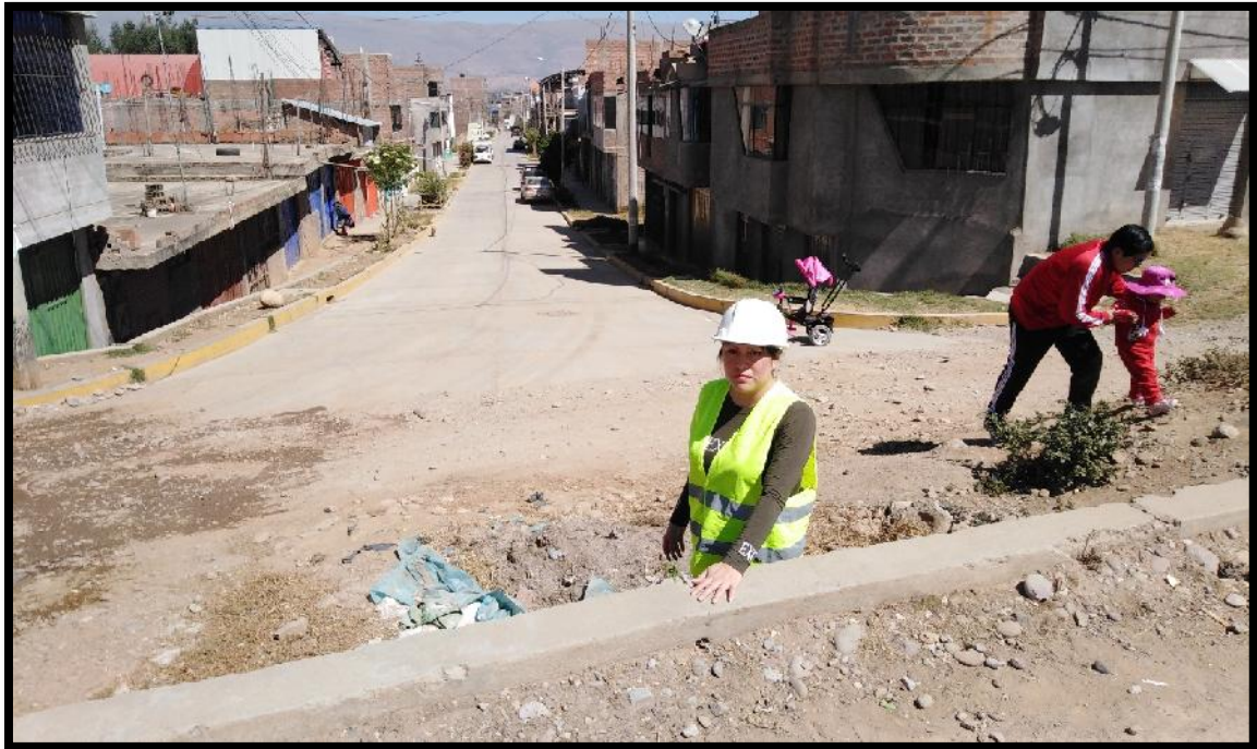
Foto N° 01. Se observa el jirón Rosario donde se encuentra el canal que llega a la avenida Flor de mayo.
