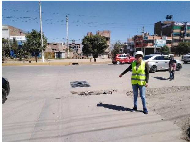
Figura 2: Rejilla donde evacuan las aguas pluviales hacia la Vía Flor de Mayo.
