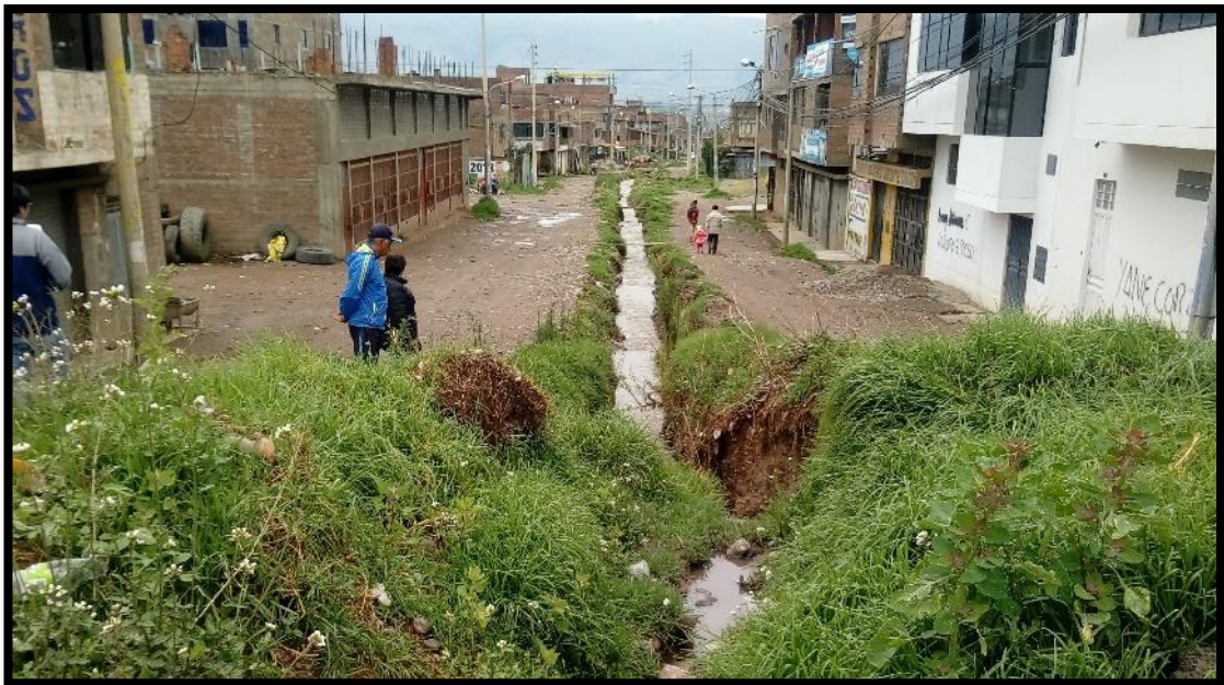
Foto N° 04. Se observa la cantidad de agua que discurre por el canal producto del rebose del canal CMIR.
