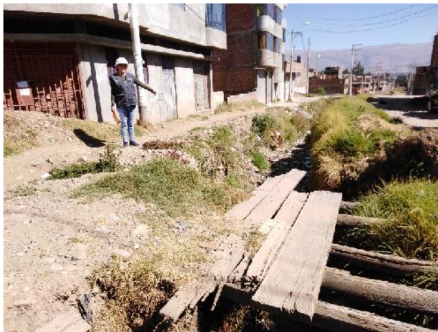
Figura 3: Situación existente del canal que pasa por la Vía Flor de Mayo.
