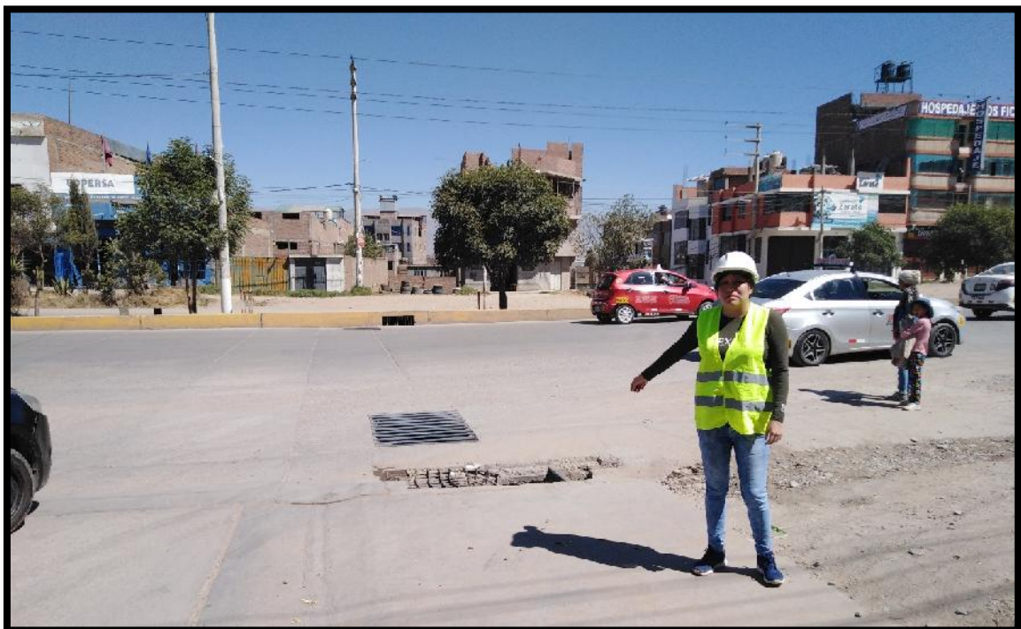
Foto N° 02. Se observa las rejillas por donde descarga las aguas pluviales de la vía Mariscal Catilla y Jirón Rosario.
