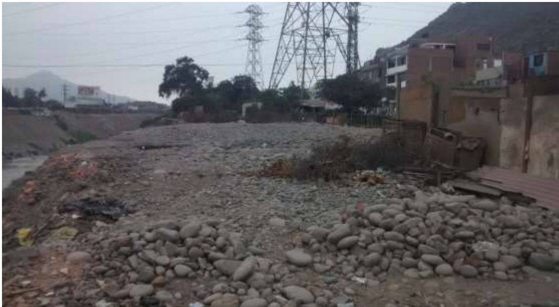
Vista de relleno para la construcción de viviendas – Fuente propia
