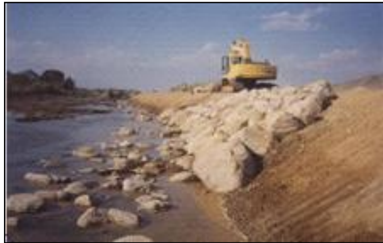
Figura 8 - Enrocado en borde del rio Rímac
