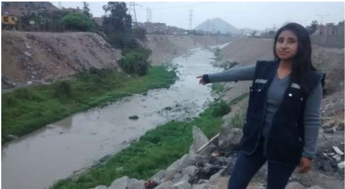
Vista del río Rímac siendo relleno sin buen correcto procedimiento – Fuente propia.
