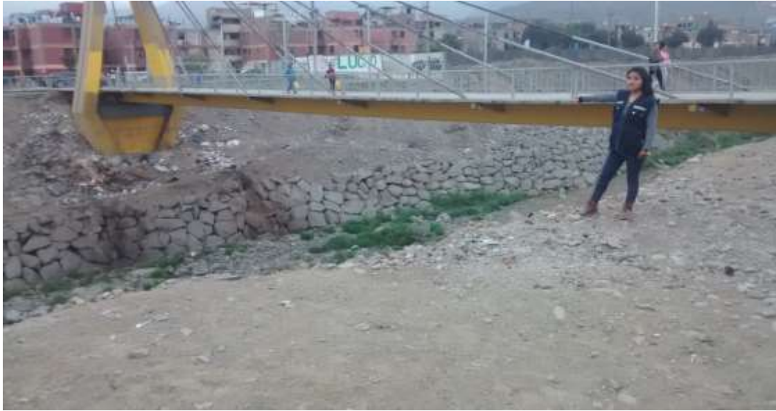
Vista panorámica del puente talavera – Fuente propia.
