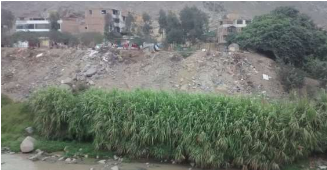
En la imagen se muestra la falta de control en el río Rímac – Fuente propia.
