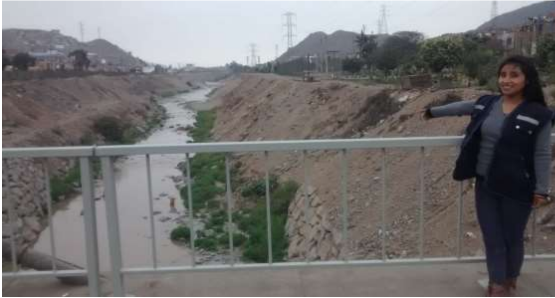
Se observa que la población no respeta los límites del río Rímac, relleno de las márgenes – Fuente propia.
