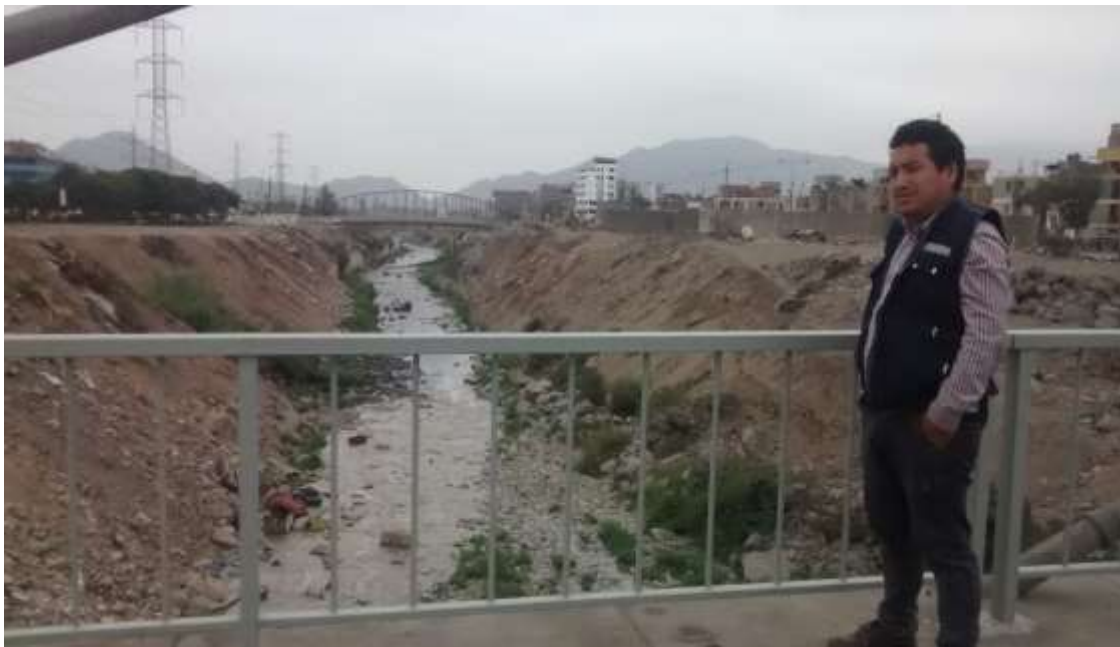
Se observa la falta de control del rio Rímac – Fuente Propia.
