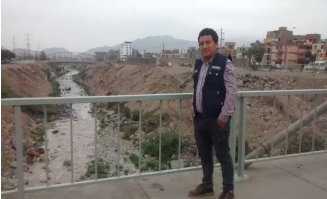
Vista del rio Rímac – Fuente propia.
