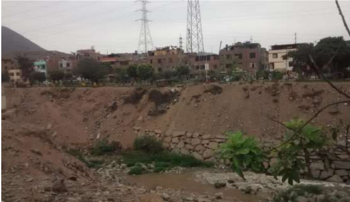
Se muestra el relleno de ambas márgenes – Fuente propia.
