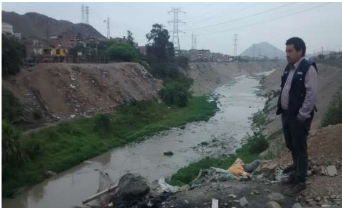
Vista del río Rímac – tramo puente talavera – Fuente propia.
