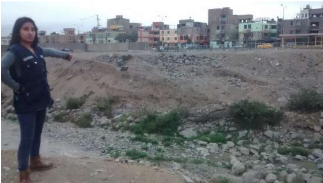
Se muestra obras que ya cumplieron la vida útil – Fuente propia.
