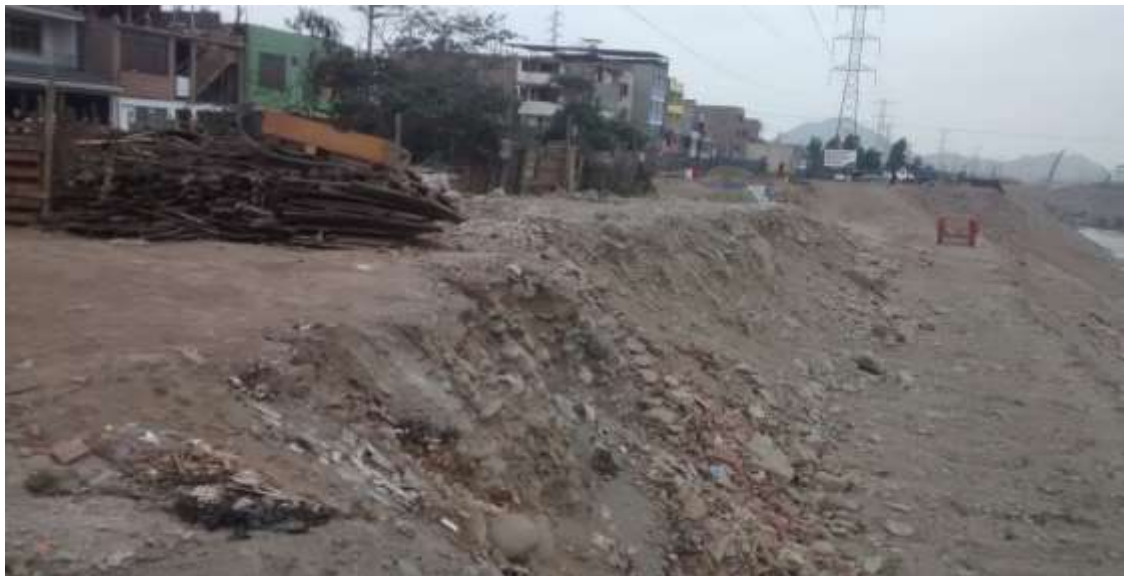
Muestra el relleno para la construcción de viviendas – Fuente propia.
