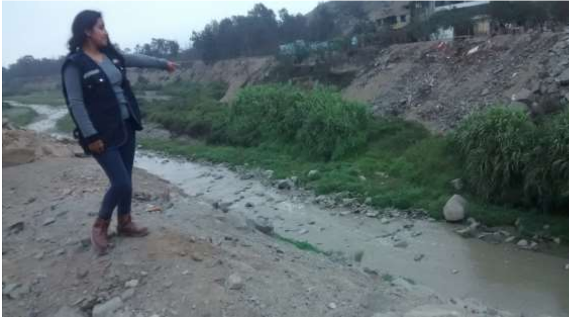
Se muestra el relleno del río siendo este quien reduce el ancho del río Rímac a respetar – Fuente propia.
