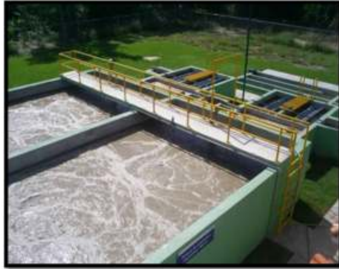
Figura N° 17 - Esquema de un sistema de tratamiento de lodos Activados
