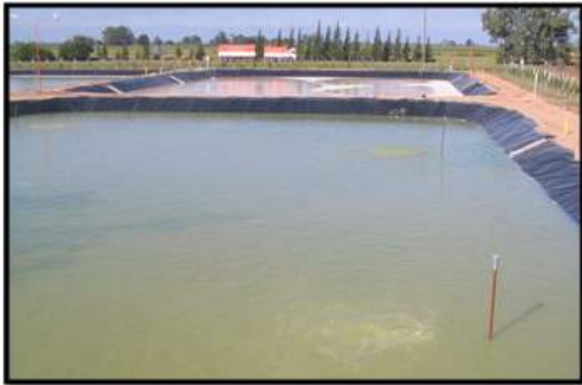
Figura N° 20 – Esquema de un sistema de Laguna de Oxidación
