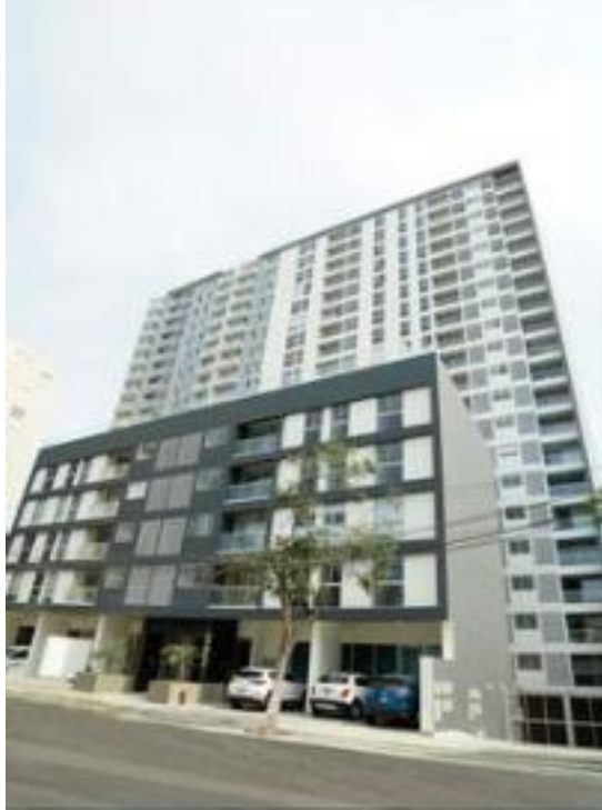
3.-Construcción real de la Vivienda Multifamiliar Nesta.
