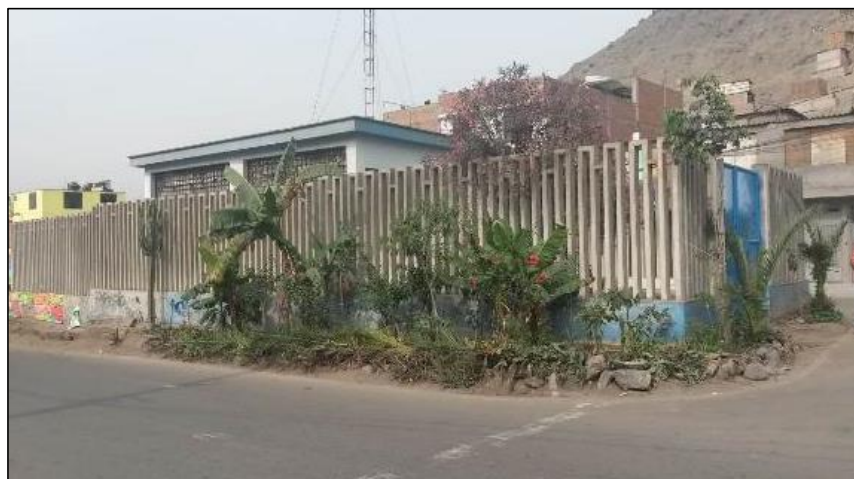
Figura 12: Vista exterior cisterna de rebombeo
