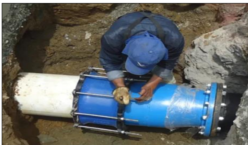
Figura 11: Instalación válvula de purga.
