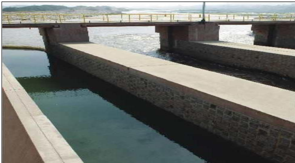
Figura 8: Bocatoma planta de tratamiento de Huachipa.
