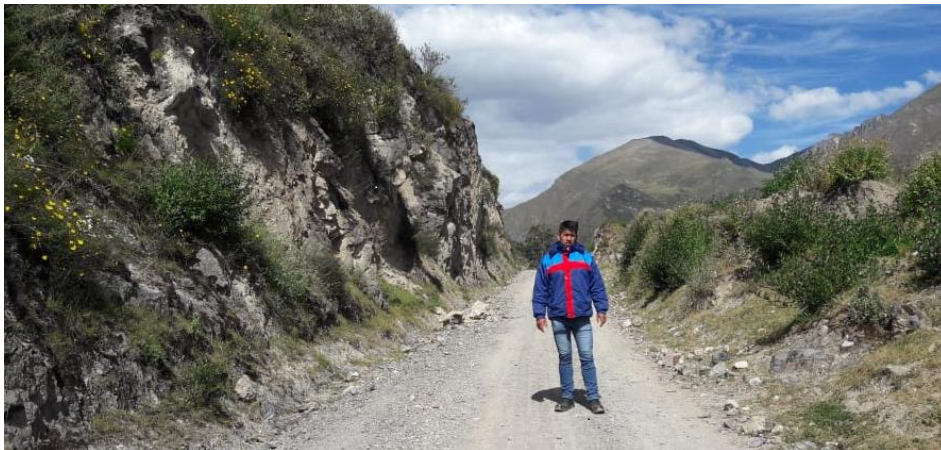
Figura: 7 vía con pendientes no adecuadas
